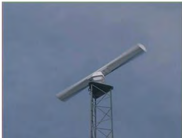
Figur 5.2.c Eksempel på C-båndsradar (Sindal) med parabol antenne og X-båndsradar (Aalborg) med slotted array antenne.
