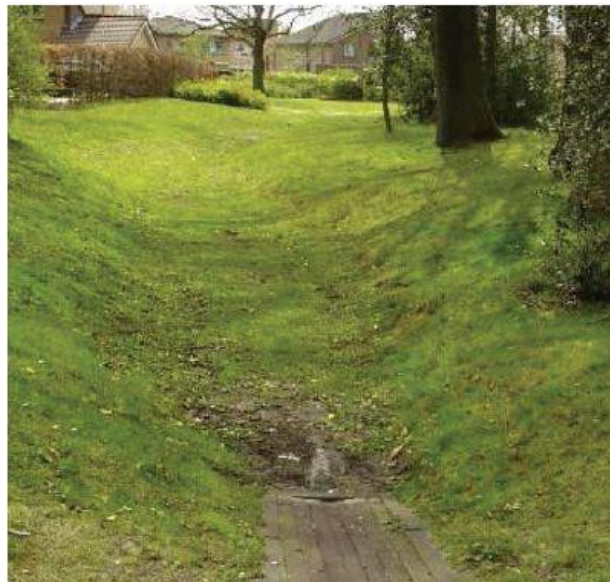
Figur 2-4 Hollandsk Wadi, udformet som et trug med en faskine under /17/
