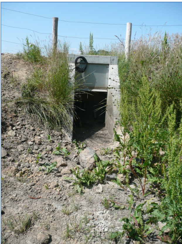
Billede 10 Bassinets udløbskonstruktion – overløbskanten er på billedet trukket op
