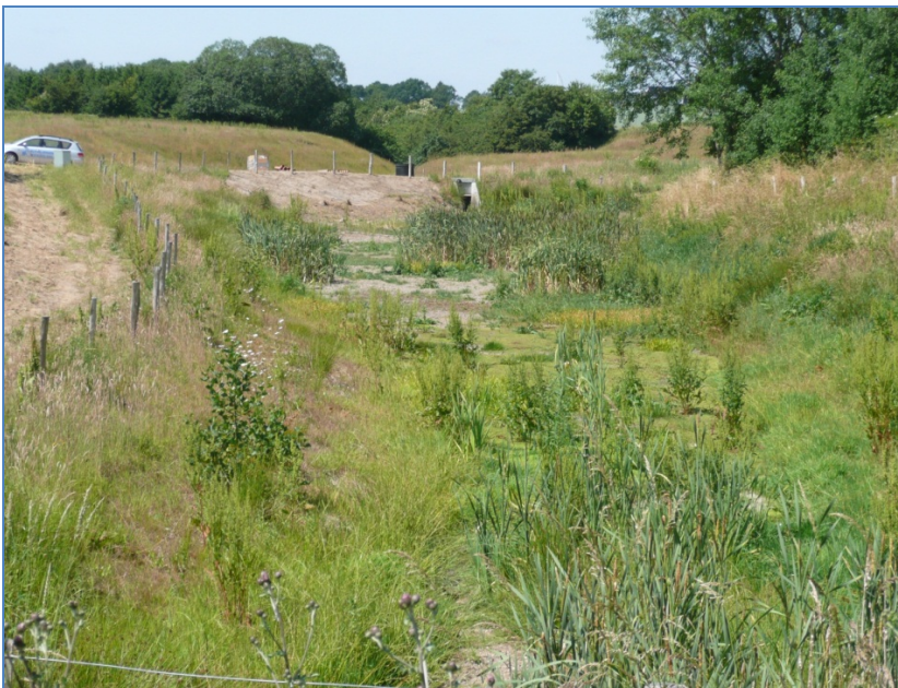
Billede 8 Renoveret dæmning i bassinets vestlige ende set fra bassinets bund
