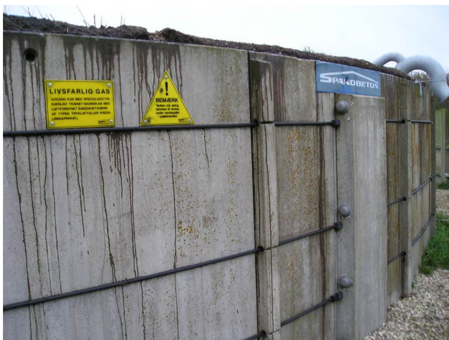
Figur 1.5 Beholdere fra Spæncom har udvendige kabler. Beholderen har låseelement til fastholdelse af kabler.
