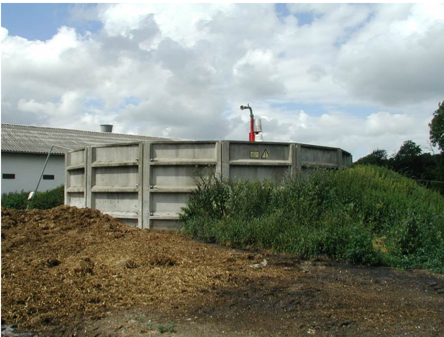
Figur 1.4 Perstrup beholder med det karakteristiske udseende. Den har udvendige kabler, som dog kan være overstøbte som her (under tilsynet skal det være muligt at færdes rundt om beholderen).
