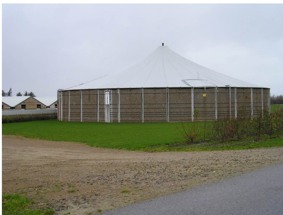
Figur 1.6 En RC-tank med teltoverdækning. Der er udvendige kabler.
