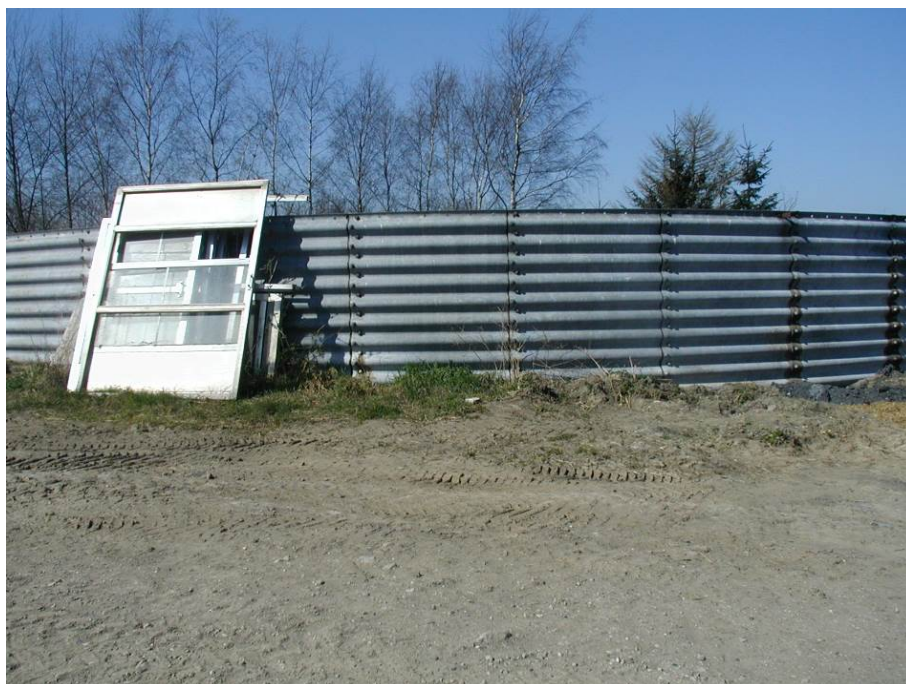
Figur 4.2 Stålbeholder med væg af bølgeprofiler. Beholderen har fundament under terrænniveau.
