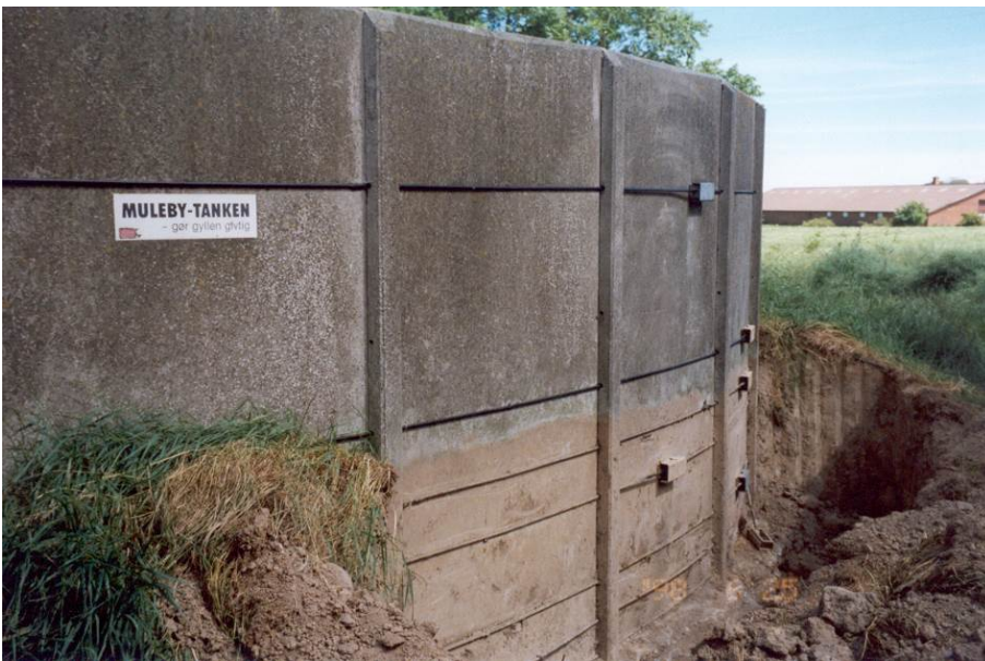
Figur 1.12 På de ældste Muleby beholdere er opspændingen sket med spredte opspændingsstykker.
