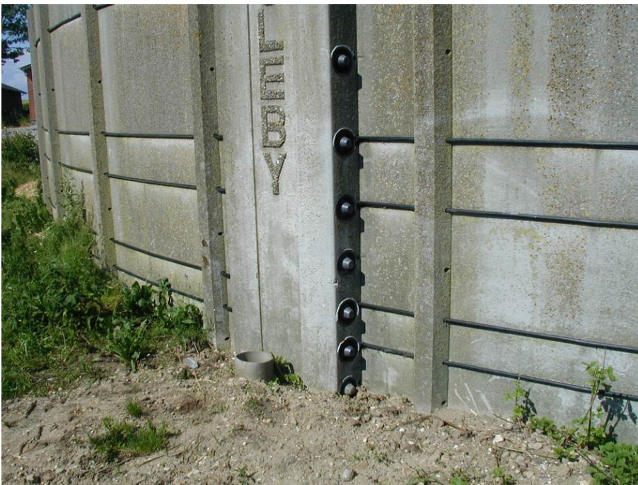
Figur 1.10 På billedet ses låseelementet på en nyere Muleby beholder. Låseelementet er skjult af en rund plastafdækning.
