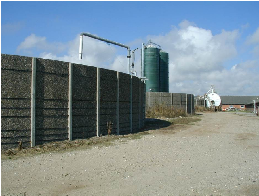
Figur 1.3 To Muleby beholdere. Muleby beholdere har udvendige kabler.
