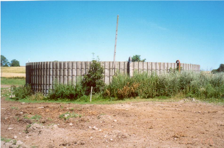
Figur 1.9 Møn tank med et karakteristisk udseende. Møn tanken har udvendige kabler (under tilsynet skal det være muligt at færdes rundt om beholderen)..
