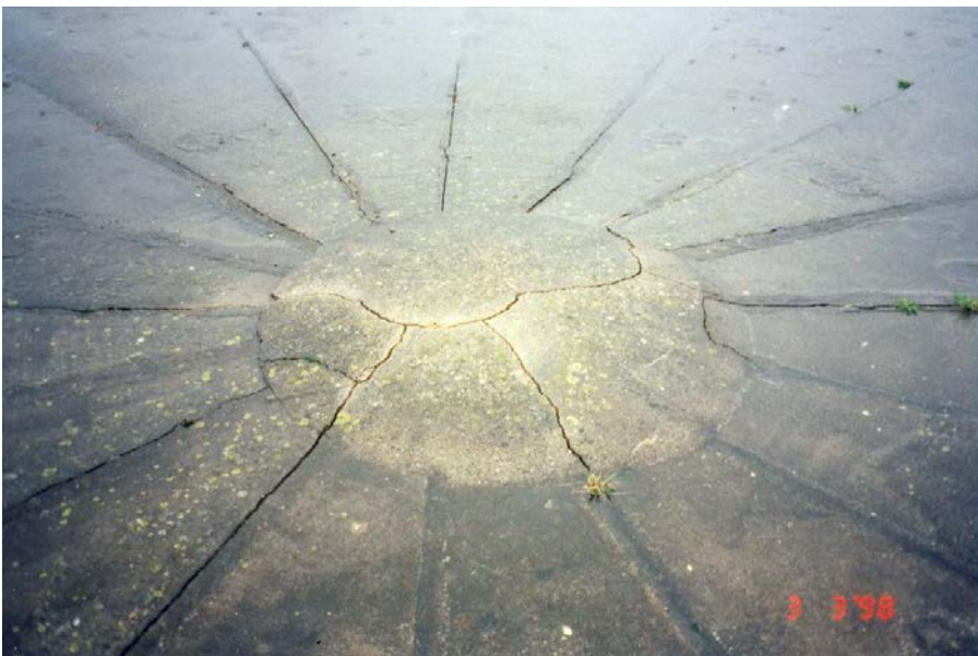
Figur 7.18 Dette er centret af et beholderlæg (set ovenfra). Revnerne antyder, at der har været bevægelser, antagelig som følge af opskudt bundplade.
