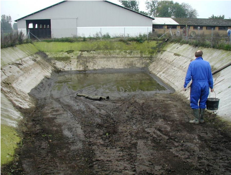
Figur 6.3 Lagune af fiberbeton.
