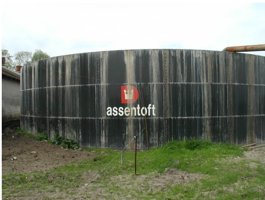
Figur 4.1 Stålbeholder med væg af glatte profiler. Beholderen har fundament i terrænniveau.
