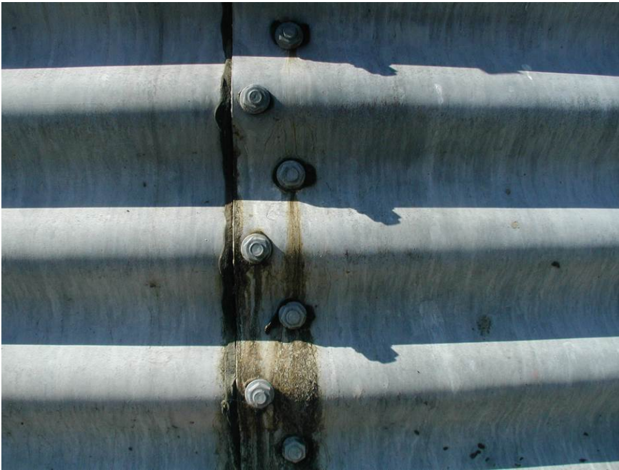
Figur 7.23 Denne stålbeholder er ikke tæt i samlingerne.
