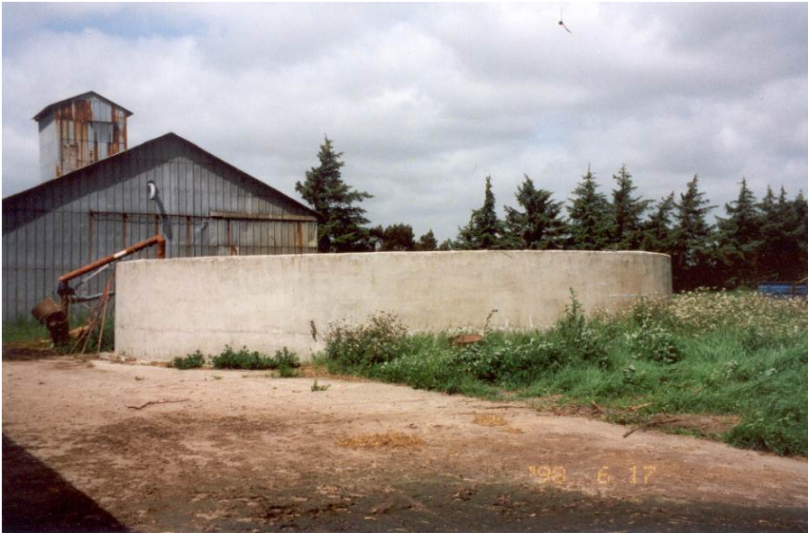
Figur 3.3 Blokstensbeholder, der er pudset.
