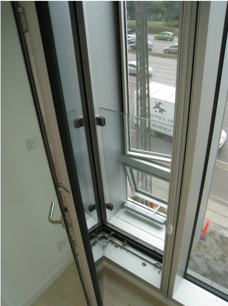
FIGUR 12 ET FOTO TAGET IGENNEM ET RUSSERVINDUE, HVOR BEGGE STORE FELTER (SERVICE OPLUK) OG SMÅ FELTER STÅR ÅBNE. DEN LODRETTE RUDE INDSAT INDE MIDT I RUSSERVINDUET ER ANBRAGT AF SIKKERHEDSMÆSSIGE ÅRSAGER.
