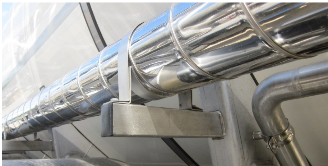
BILLEDE 50 GAMMELT DESIGN AF SLANGERØRSHOLDEREN.
