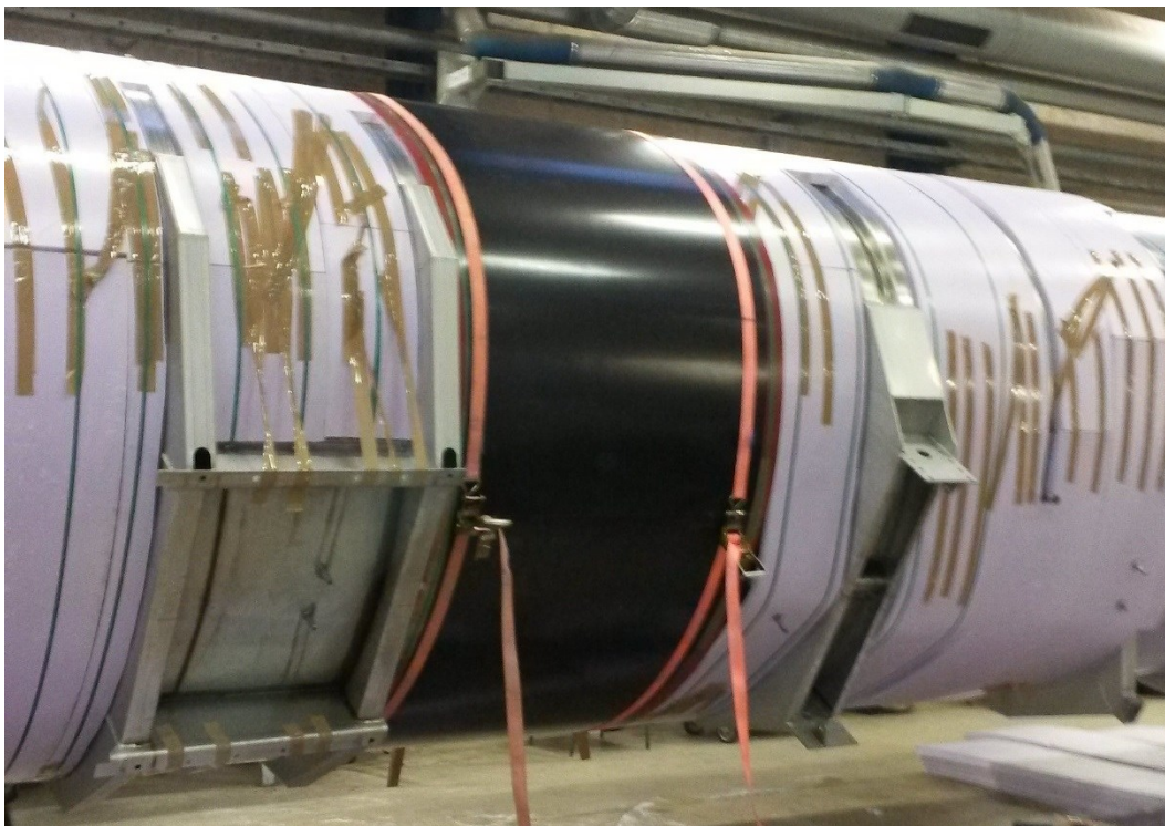
BILLEDE 37 TESTMONTAGE AF KULFIBER KAPPE PÅ ISOLERET MÆLKETANK.
