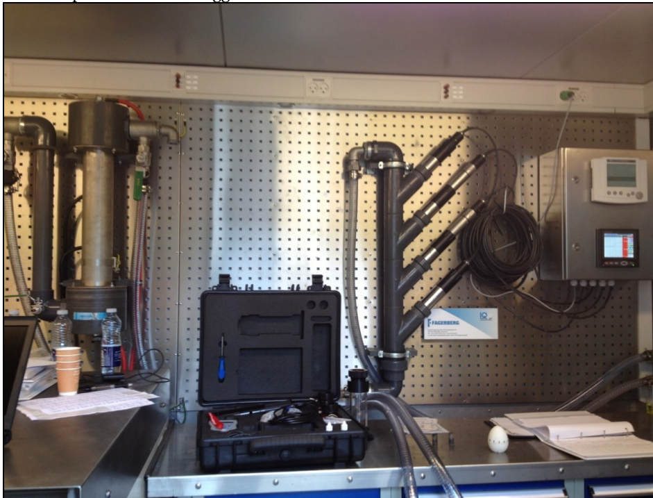
Foto nr. 8. Procesmålingsudstyr. I midten ses manifold med elektroder og til højre ses datalogger.
