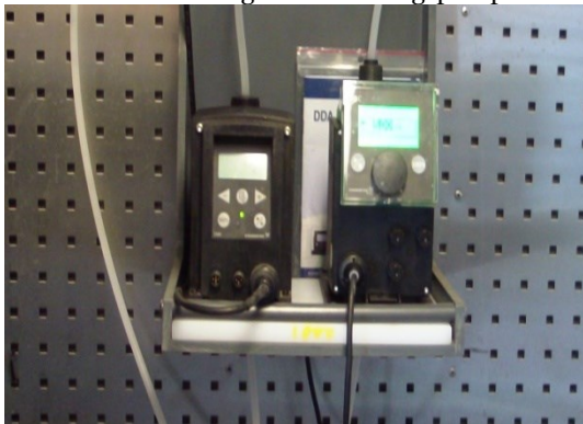
Foto nr. 3. Doseringspumper (0-5 l/time og 0-10 l/time)
