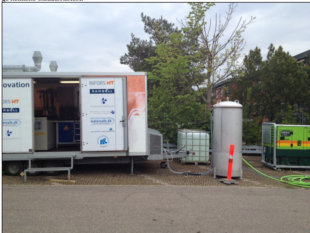
Foto nr. 1. Testenhed, kølevandstank, generator, og aktivt kulfilter.
