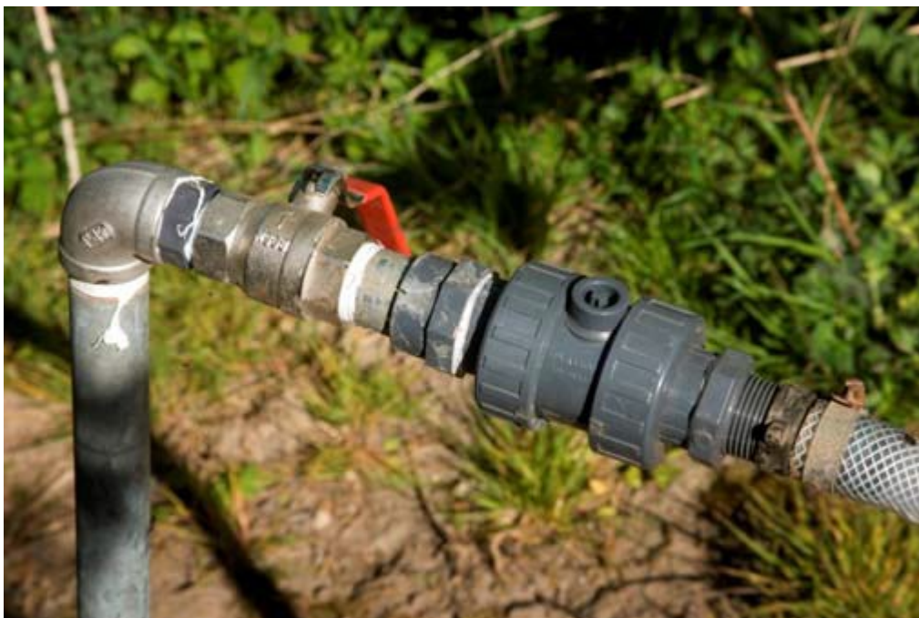
KONTRAVENTIL PÅ TAPSTED ER EN LØSNING TIL AT FORHINDRE TILBAGELØB TIL LEDNINGSNET FOTO: JENS TØNNESEN, LANDBRUGSMEDIERNE
