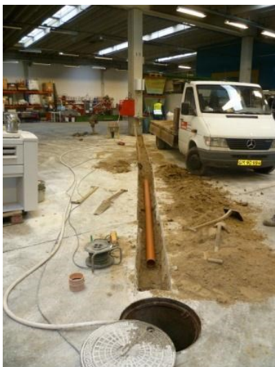
BILLEDE 2: ETABLERING AF GULVAFLØB
