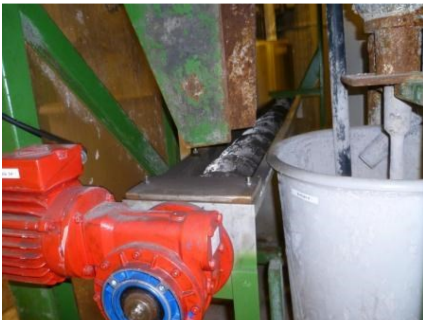
BILLEDE 8: NY TRANSPORTØR FOR RGA FRA CENTRIFUGE TIL SKYLLETANK
