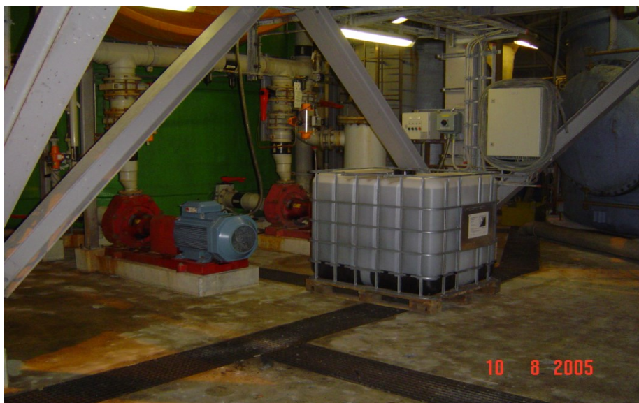
Figur 10: "Quench HCl scrubber tank" (grøn tank i baggrunden) prøveudtagningssted på VF for HCl scrubber væske og i forgrunden ses en 1 m 3 palletank til HALOSEP forsøgene.
