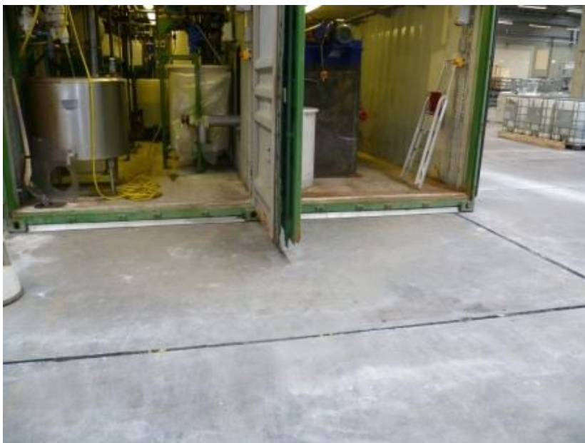
BILLEDE 5: GULV (FUGER) OG CONTAINERBUND TÆTNET MOD SPILD
