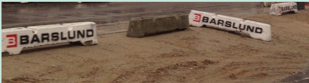
FIGUR 14 FRISK OVERSKUDSBETON ANVENDES SOM AFSPÆRRING. FOTO: DORTHE MATHIESEN.
