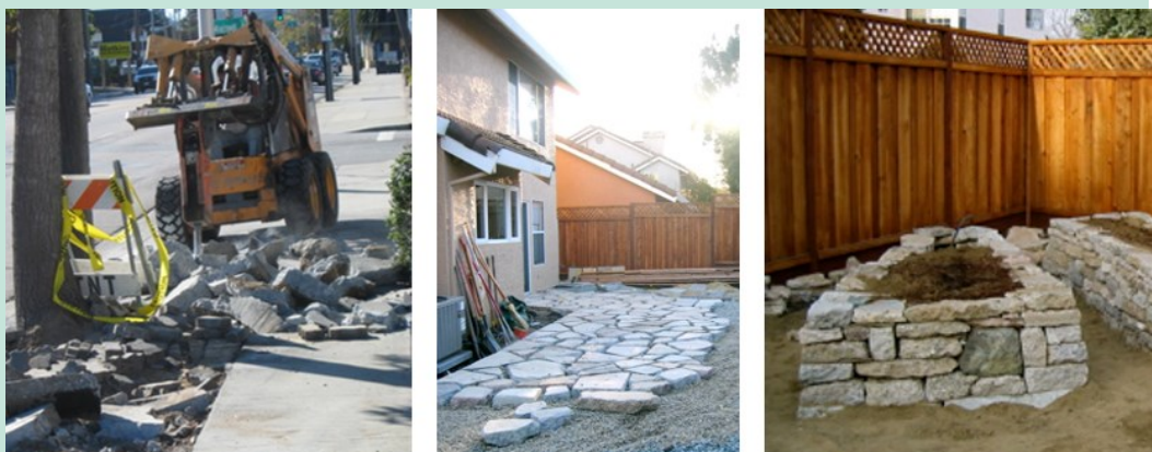
FIGUR 12 NEDDELT BETON BENYTTET SOM BELÆGNINGSSTEN. FOTOS: TERRA NOVA ECOLOGICAL LANDSCAPING.
