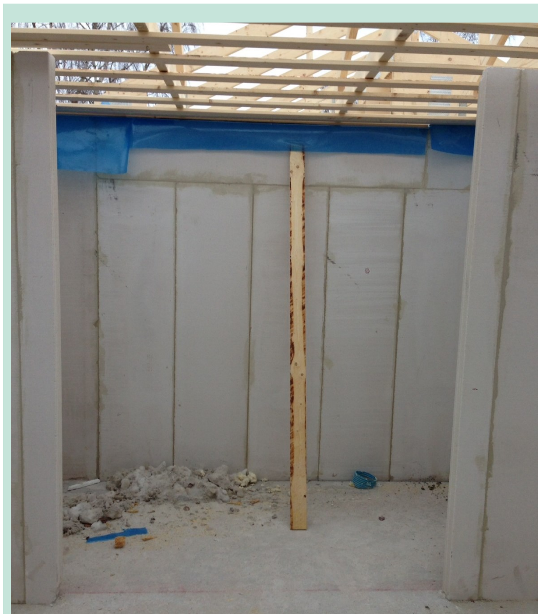
FIGUR 8 DIREKTE GENRUG AF BETONELEMENTER KAN FORESTILLES ANVENDT I HUSBYGGERI. FOTO: ANDERS GREVE.
