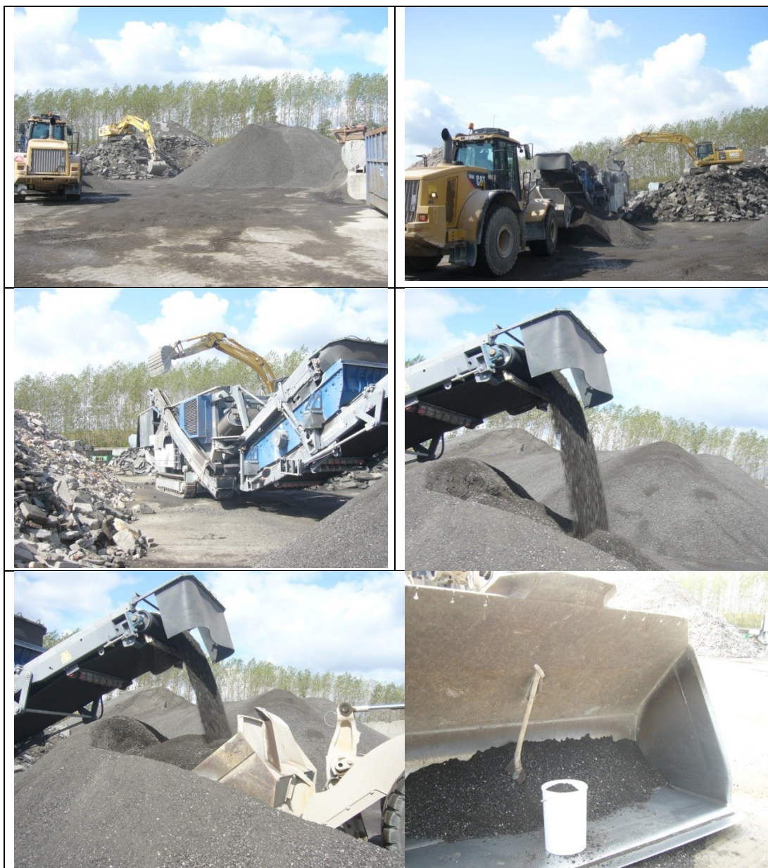
RGS 90 PÅ SELINEVEJ, KØBENHAVN S: PRØVETAGNING AF KNUST ASFALT
