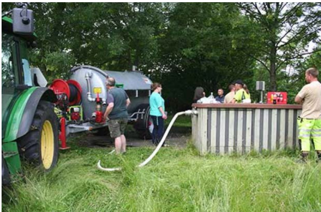
FIGUR 2-2 VANDKIOSK MED SEKUNDAVAND I KØBENHAVN. SEKUNDAVANDET ER LETTERE FORURENET GRUNDEVAND FRA EN NEDLAGT KILDEPLADS.
