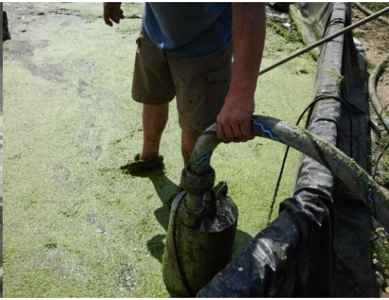
Montering af pumpe
