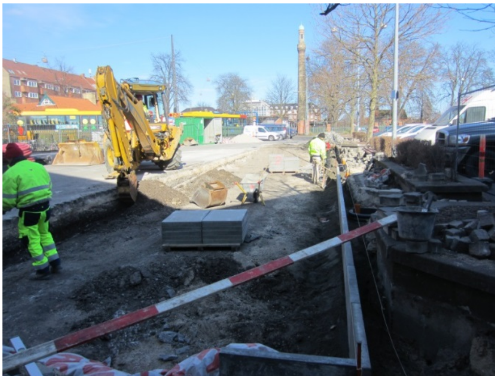
BILLEDE 17 PLACERING AF KØREBANEFLISERNE
