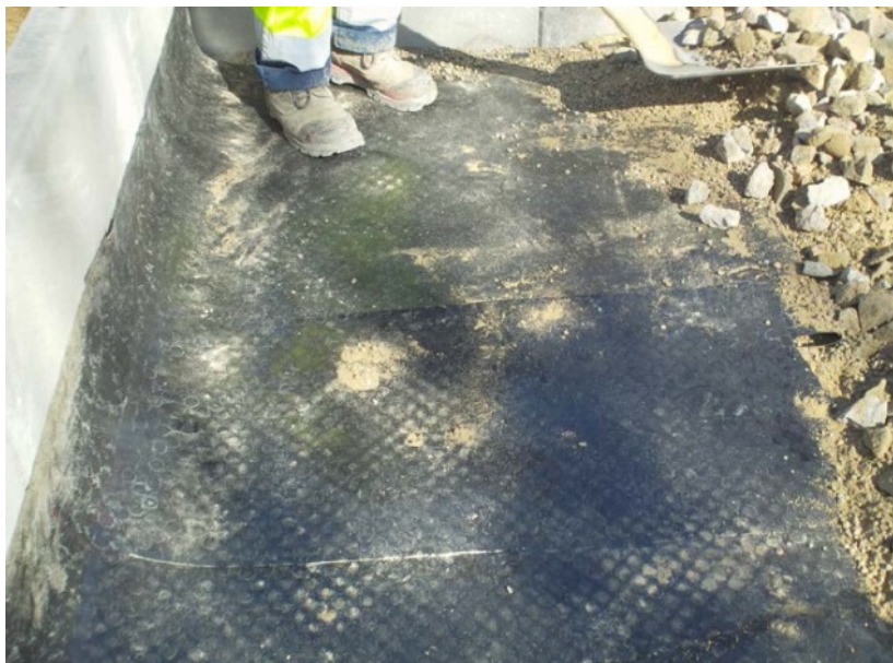
BILLEDE 20 UDLÆGNING AF MEMBRAN OG PLATONPLADER
