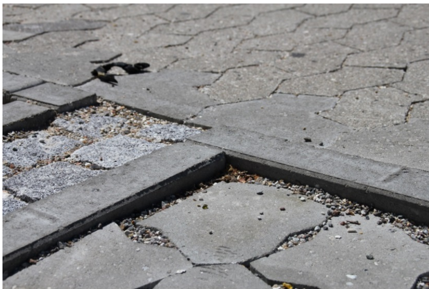
BILLEDE 3 OPKANT PÅ TESTFELT ETABLERET MED LODRETSTÅENDE KØREBANEFLISER SAMT RENDER SAT I CHAUSSÉSTEN
