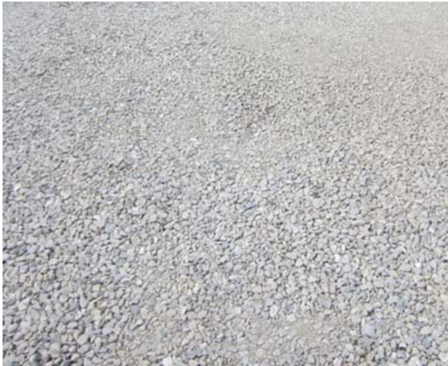
BILLEDE 13 NEDKNUST BETON
