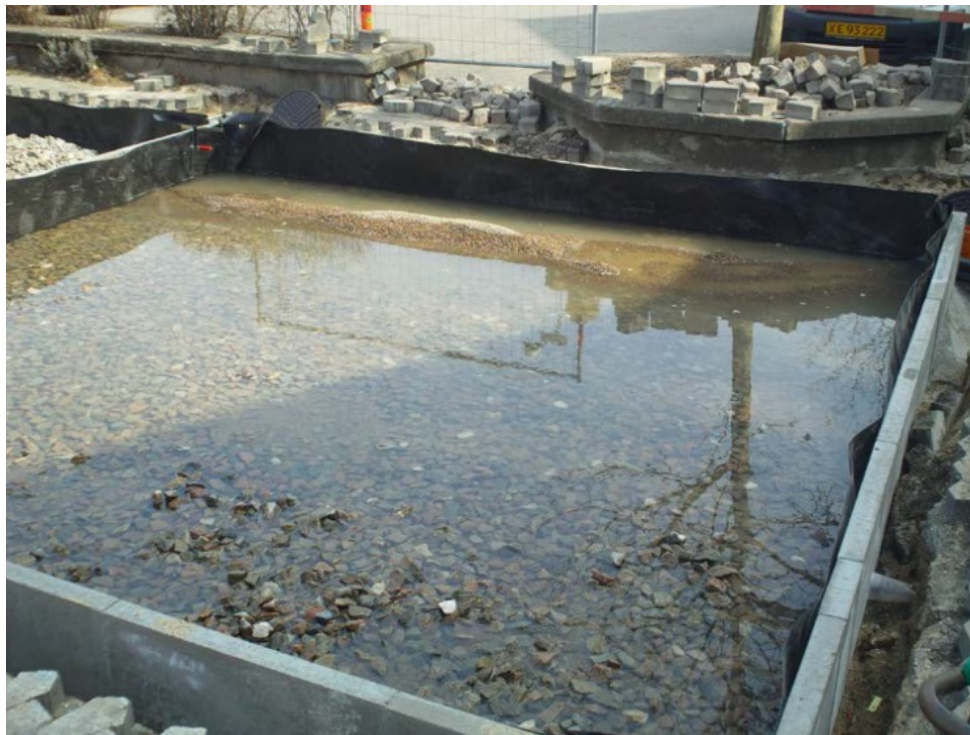
BILLEDE 23 KONTROL AF OM MEMBRANEN ER TÆT
