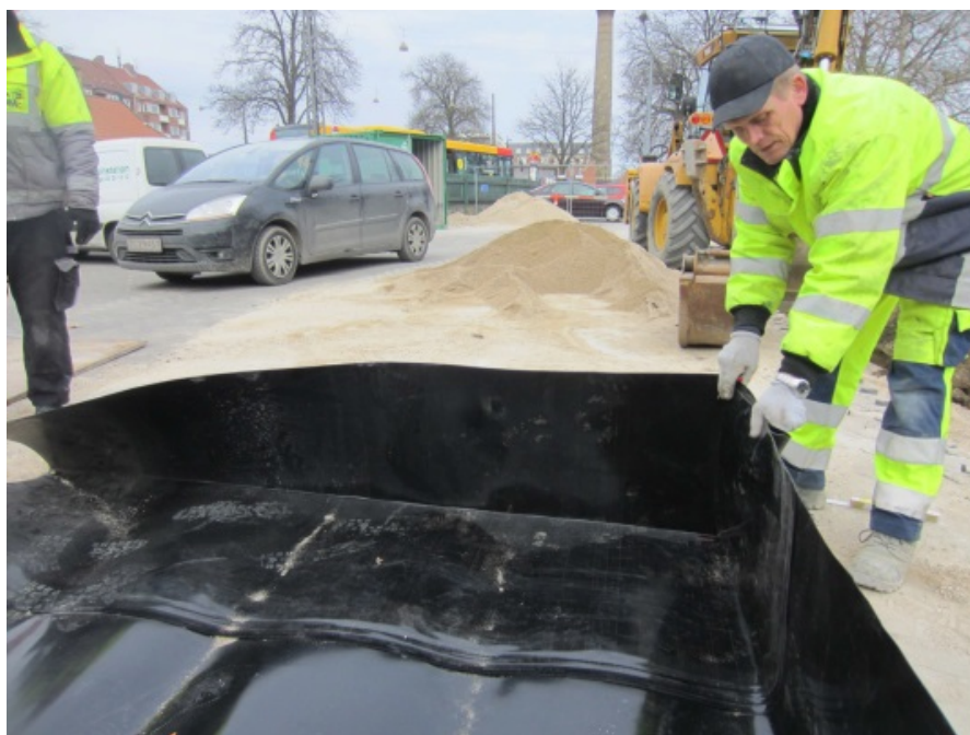
BILLEDE 19 KONTROL AF MEMBRANERNES STRÆKBARHED
