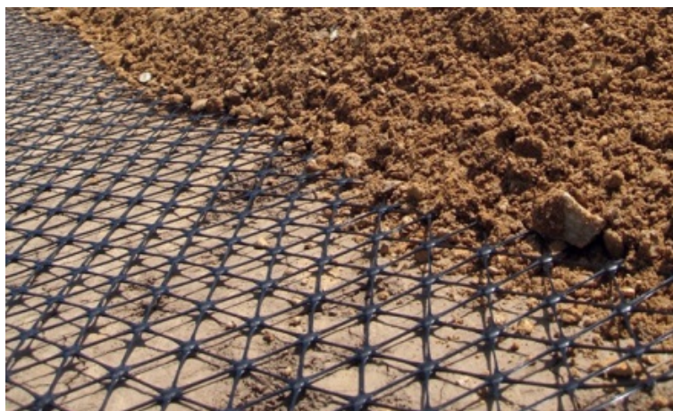
BILLEDE 18 FORBEDRING AF BÆREEVNE MED GEONET TENSAR TRIAX TX160
