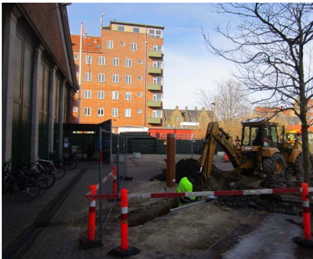
BILLEDE 15 TILSLUTNING TIL KLOAK OG BRØND ETABLERES
