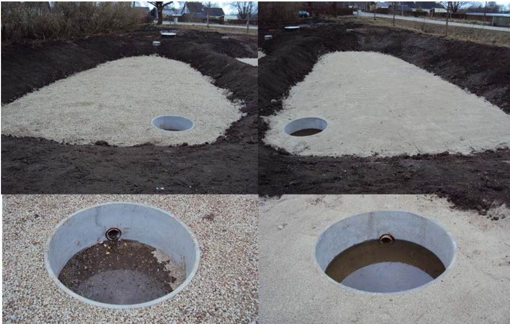
BILLEDE 9 DE TO FILTERE UMIDDELBART EFTER ANLÆG (ØVERST) – BETONFILTER TIL VENSTRE OG SANDFILTER TIL HØJRE. NEDERSTE BILLEDER AF DE TO ÅBNE BRØNDE HVOR VANDET KOMMER IND I FILTERNE OG DERFRA LØBER UD OVER FILTERNE OG VERTIKALT IGENNEM FILTERMATERIALET.
