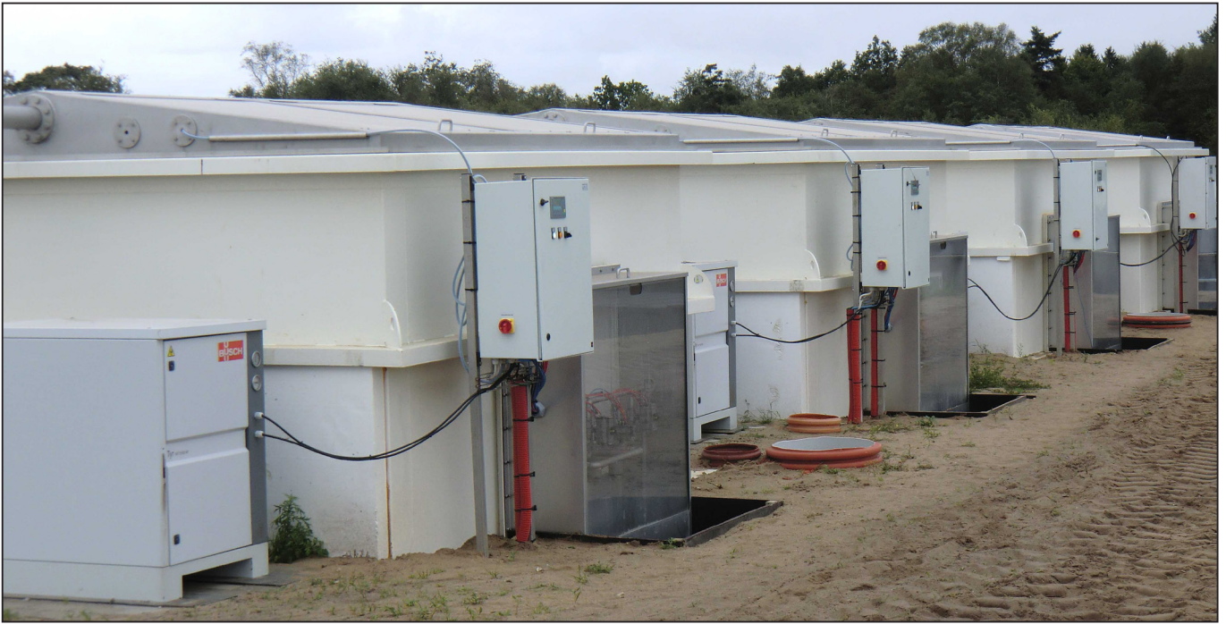
Membrananlæg til spildevandsrensning, KMC Brande. Fungerer som erstatning for efterklaringstank.
