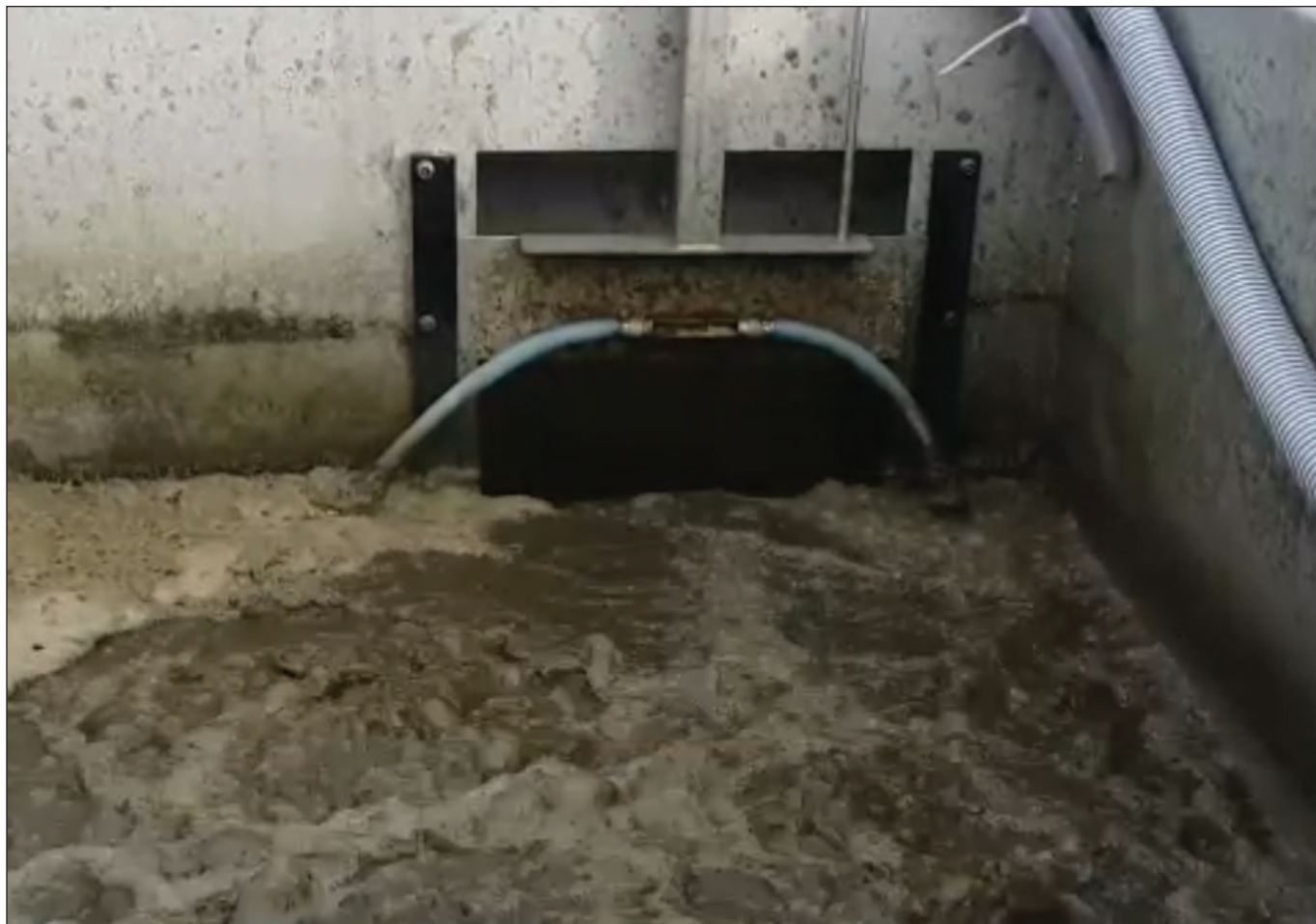
Returslam fra efterklaringstank fra 6000-7000 mg/ss.
