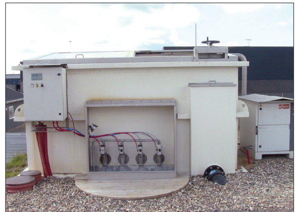
Opstillet kassette med et flow fra 20-800 m 3 /døgn.
