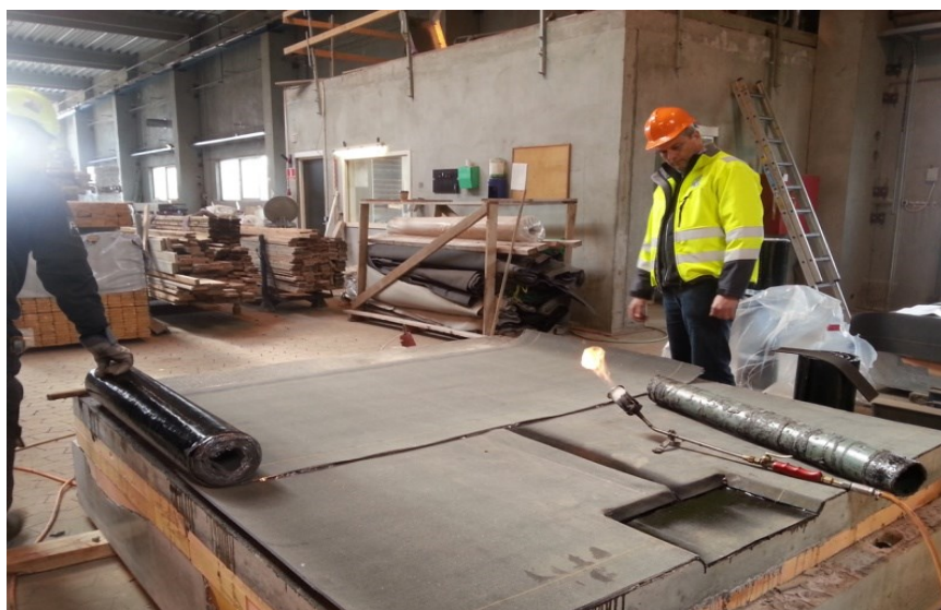
Figur 9 Fuldsvejsning af tagpap til betonpladen med forsinking til tagbrønde
