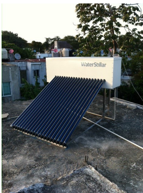
Figur 11 Her ses enheden på familiens tag. Dataloggeren ses øverst til højre. De hvide rør på hustaget er rørføringen til/fra enheden.
