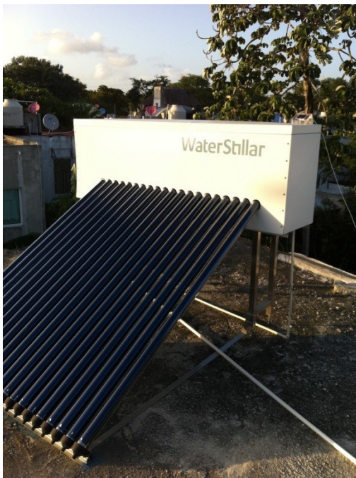
Figur 32 Generation 3. Den hvide kasse har den ulempe, at regnvand ikke løber af.
