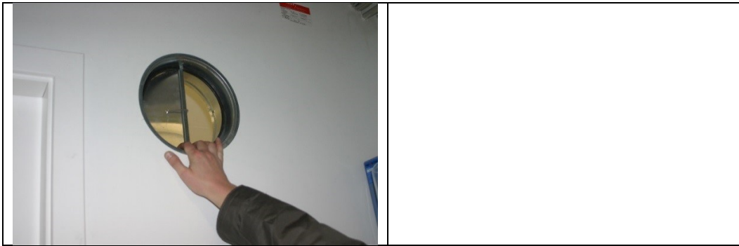
FIGUR 5 VENTILER TIL TRYKUDLIGNING I TILFÆLDE AF BRAND
