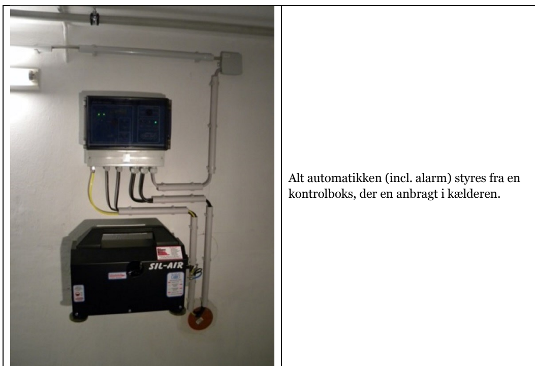
FIGUR 28 BY-PASS LØSNING I 2-FAMILIESHUS PÅ FREDERIKSBERG
