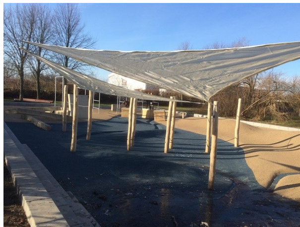
BILLEDE 20 FÆRDIGT ANLÆG.
