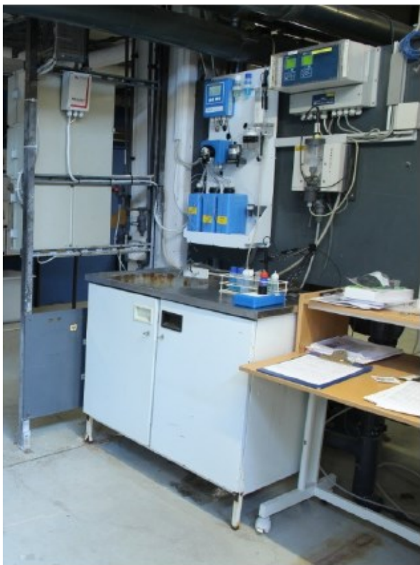
Figur 2.5 Foto af AMI Codes-II CC måleren monteret i Gladsaxe Svømmehal
