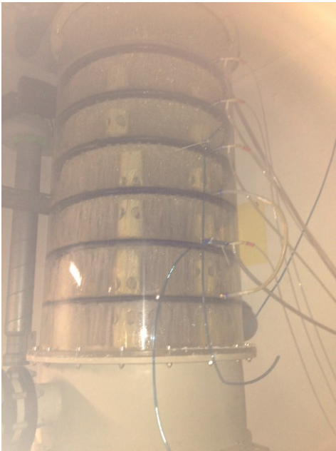
Figur 2.3 Luftstrippingsteknologi monteret i Gladsaxe Svømmehal
