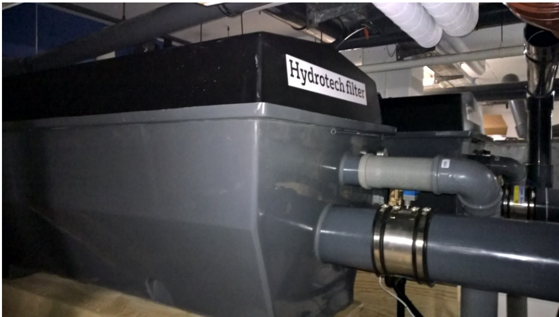
Figur 2.2 De to parallelt installerede tromlefiltre med InBlue Sub 5 filterdug.
