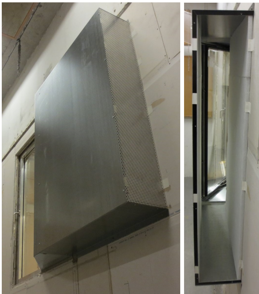
Illustration 9M Foto fra udvendig side af prototypeløsningen. Venstre foto viser konstruktionen skråt nede fra, hvor fuglegitteret kan ses. Højre foto viser konstruktionen set fra åbningen i prototypen, hvor 20 mm absorber er tilført top, bund og sider. Se desuden Illustration 9A.
