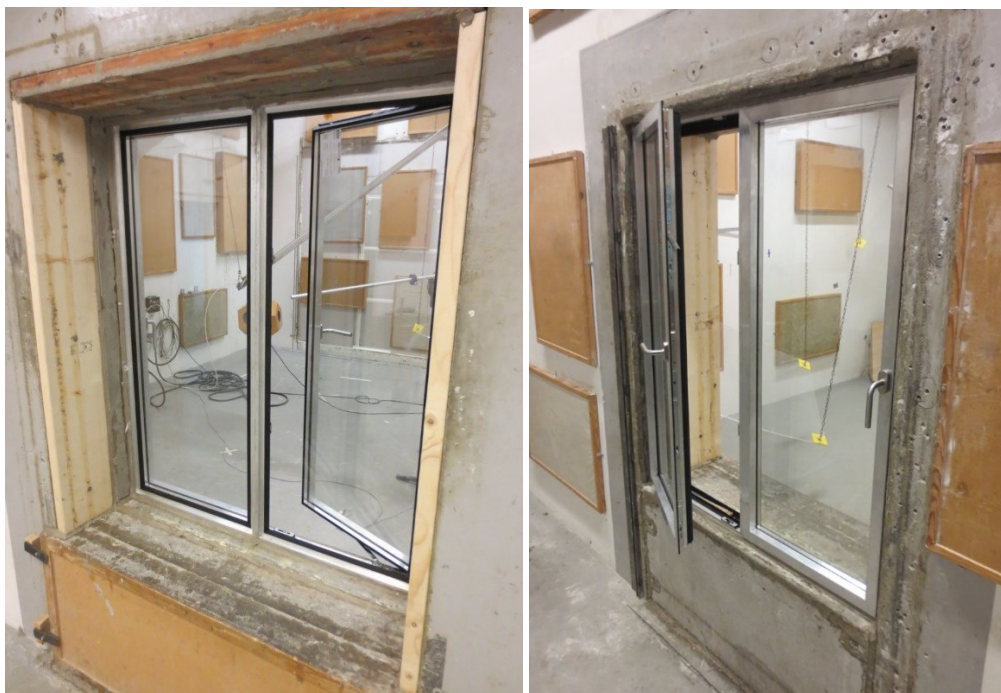
Illustration 8B. Fotos af reference vindue: Enkelt tofløjet vindue her vist fra både indvendig side (venstre foto) og udvendig side (højre foto).
