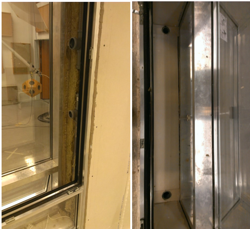
Illustration 7D. Fotos af vinduet med indsatte resonatorer. Venstre foto viser resonatorerne monteret i den lodrette karm, mens højre foto viser resonatorerne monteret i den vandrette karm (bunden).
