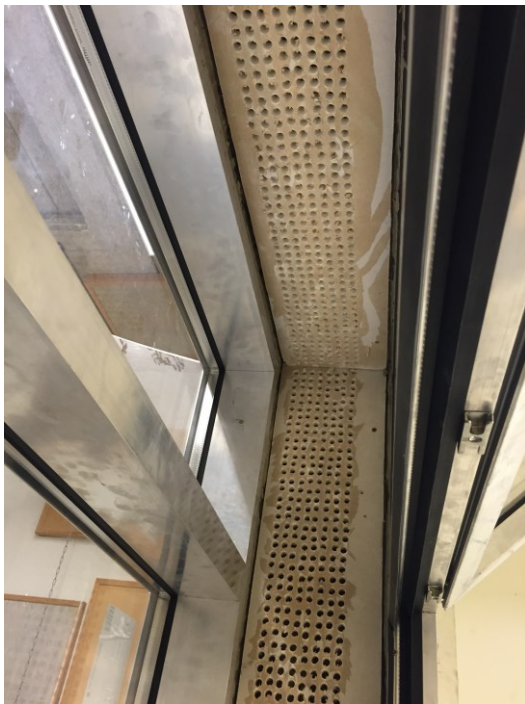
Illustration 7E. Foto af vinduet monteret med 34,91 % perforeret karm. Fotoet er taget op mod det øvre hjørne.
