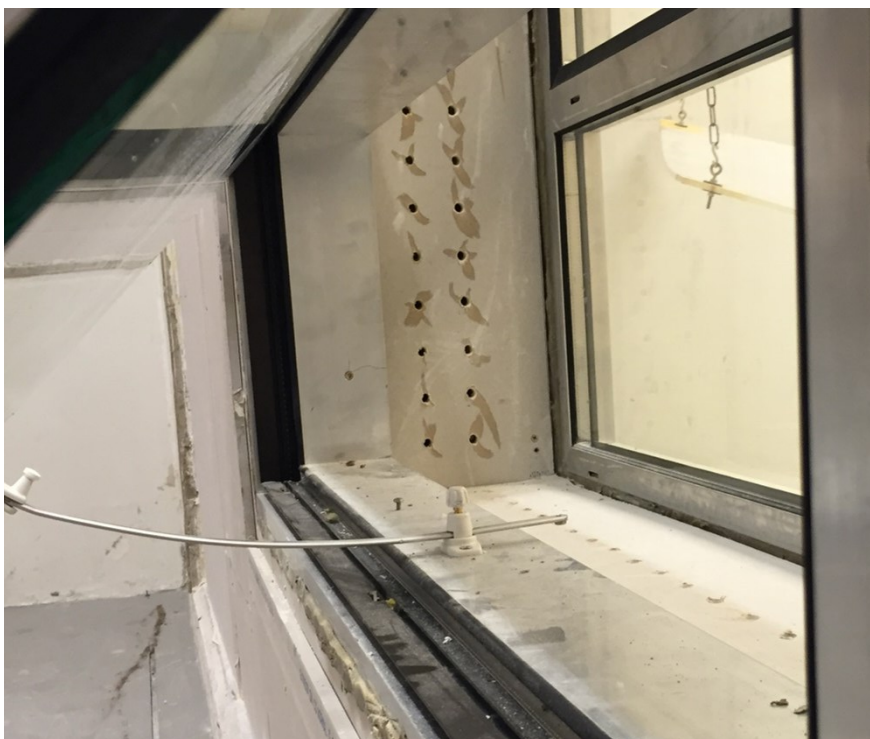
Illustration 7A. Foto af 'russervindue' med perforerede plader i karmen.
