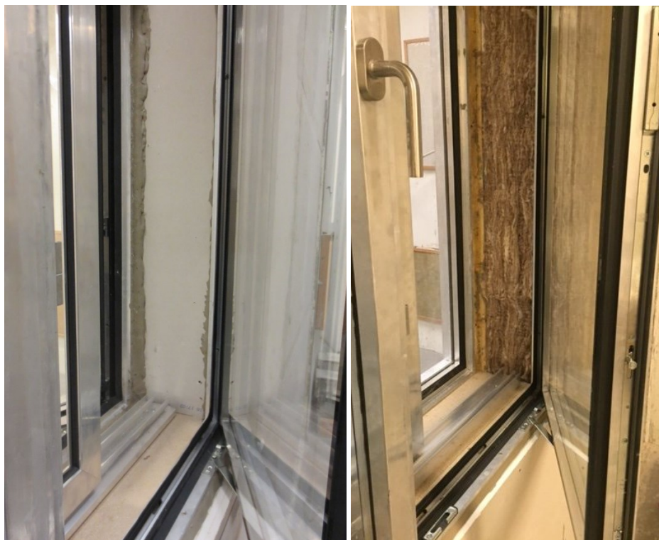
Illustration 8N. Fotos af anvendt karmabsorbent. Venstre side: Ingen absorbent (ubrudt gipsplade). Højre side: Åbent ind til anvendt mineraluld i den dobbelte gipspladevæg.
