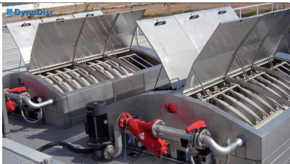
Eksempel på brug af DynaDisc™ skivefilter. gengivet med tilladelse fra EnviDan.
