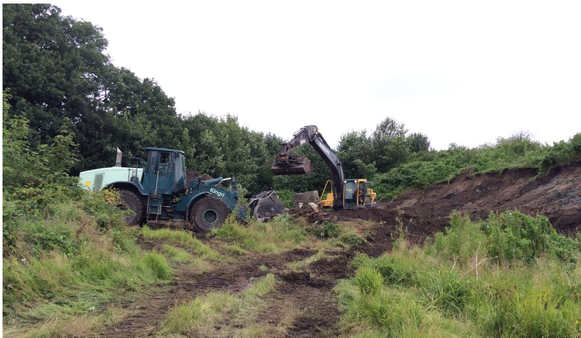
Foto 1. Afgravning af dækjord
