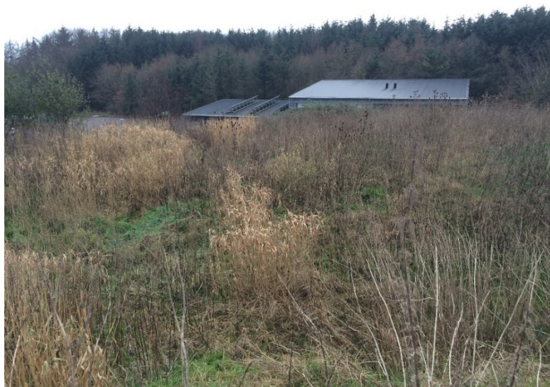
Billede 7.3 Parti fra toppen af affaldsdepotet før igangsættelse
