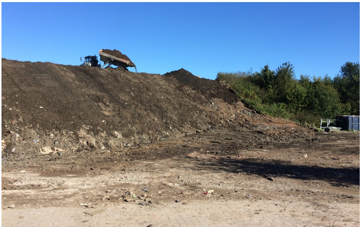
Foto 9. Udlægning af afdækningsjord efter retablering af deponi.
