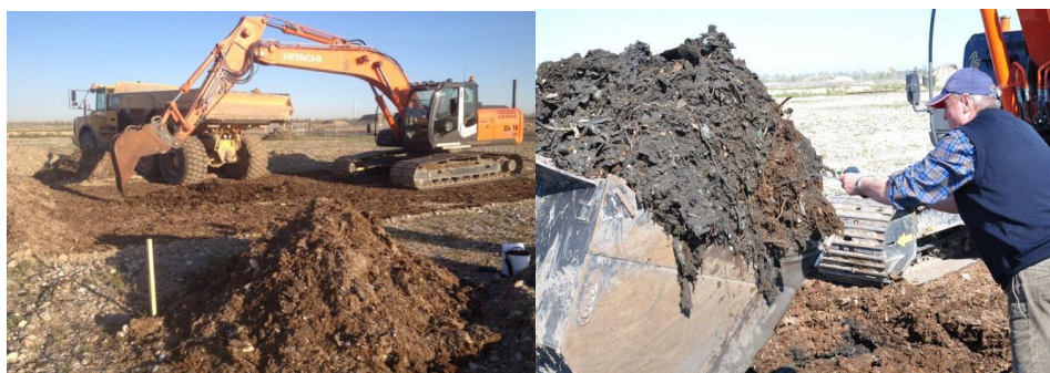
Figur 3.15: Udgravning af shredderaffald i celle 2.1
