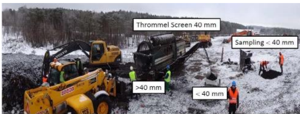
Figur 4.17: Udgravning og sortering på deponiet Kudjape
