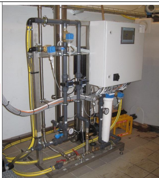
Dansk nanofilter med forfilter fra BWT til rensning af perkolat fra lossepladser, ca. 500 l/h.
