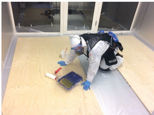
Figur 2. Kammer klar til lakering af 4 m 2 gulv.
