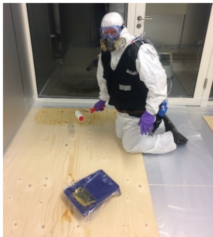
Figur 3. Lakering af gulv (TV) og maling af gulv (TH).
