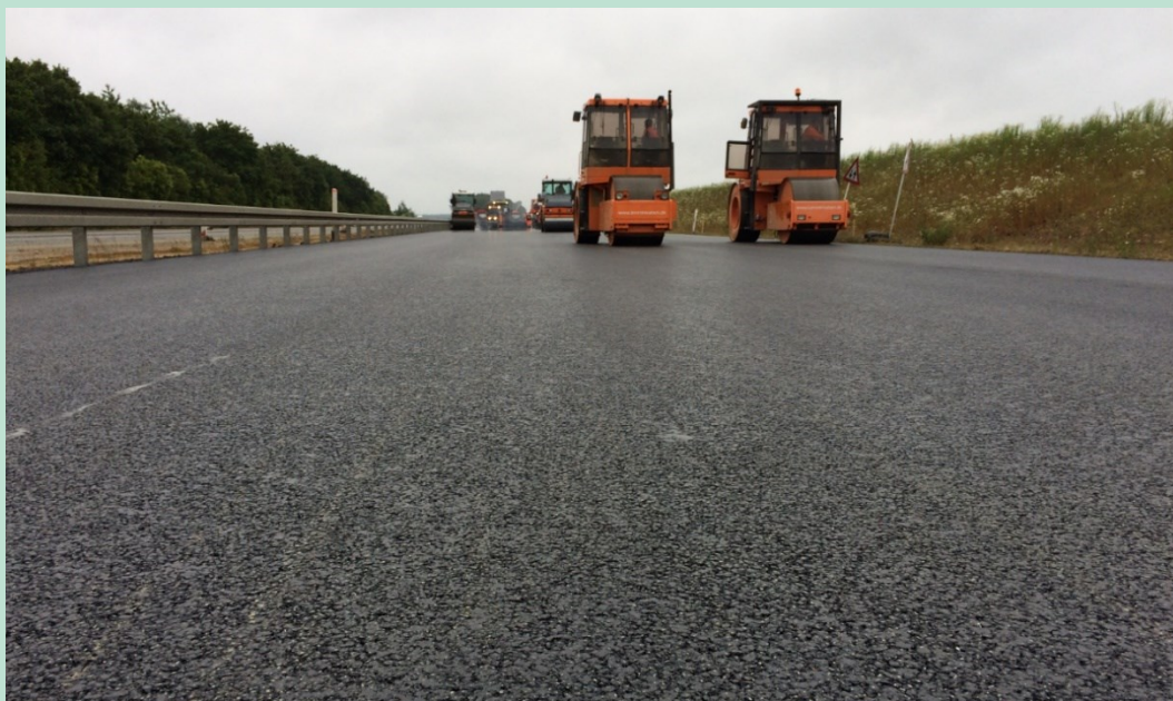
FIGUR 13.0.1. Udlægning af SMA med 30 % genbrugsasfalt på Herning-Holstebro motorvejen i juni 2017. Det var første gang at der blev udlagt SMA-slidlag med genbrugsasfalt på en dansk motorvejsstrækning. (Foto: TI).
