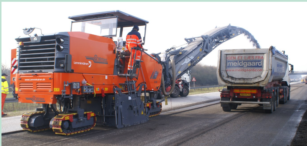
FIGUR 4.2.3. Ved affræsning af slidlag for sig kan materialet bedre genbruges højest oppe i "værdikæden" i nye varmblandede asfaltslidlag (Foto: YIT).
