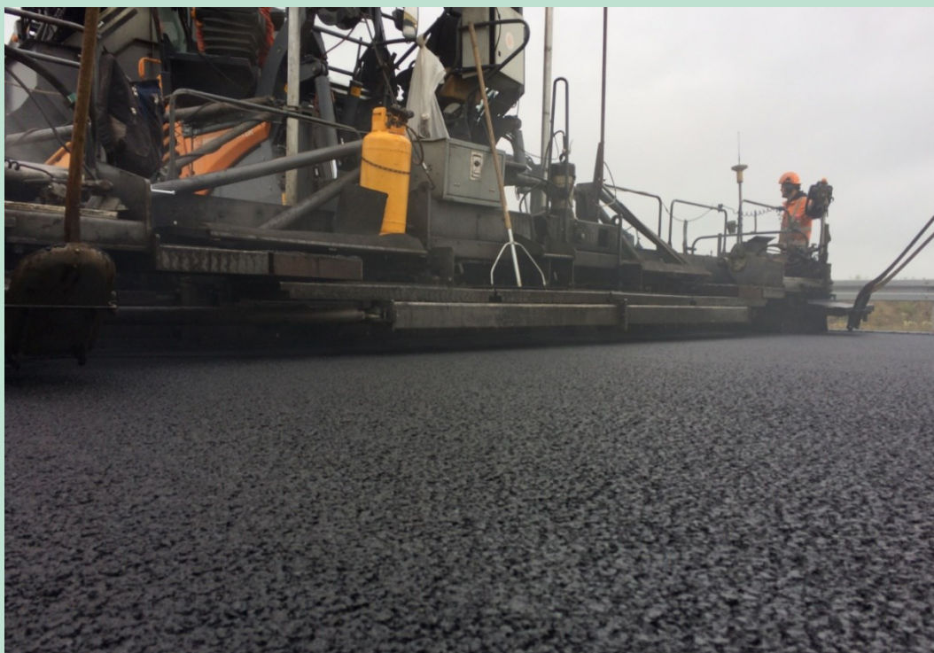
FIGUR 13.3.3. SMA 11 med polymermodificeret bitumen og 30 % genbrugsasfalt - Meget ensartet udseende bag udlæggeren og ingen tegn på afblanding eller klumper. (Foto: TI).
