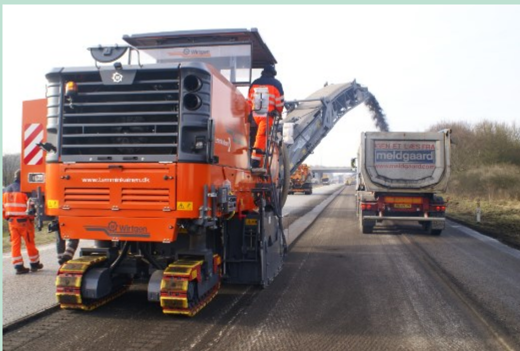
FIGUR 7.0.1. I udviklingsprojektet konkluderes, at valget af fræseprocedurer har indflydelse på den resulterende genbrugsasfalts kornkurve og dermed anvendelighed (Foto: YIT).
