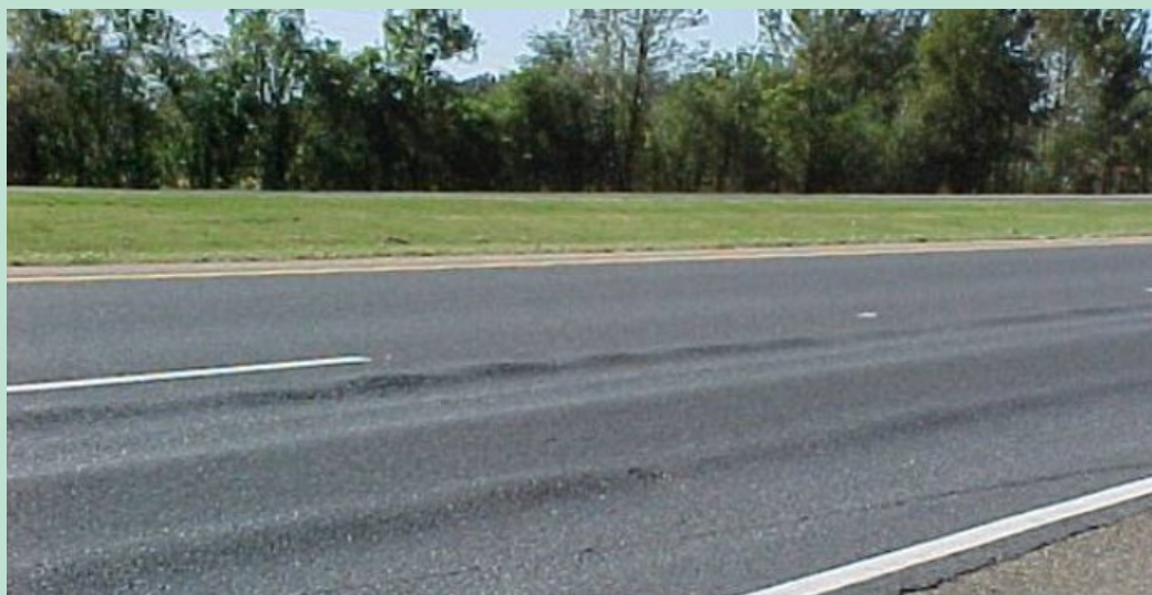
FIGUR 6.3.1: Hvis asfalt på tungt trafikerede veje fremstilles med for svage sten og blødt bindemiddel er der forøget risiko for sporkøring (plastisk deformation) fra de tunge køretøjer.
