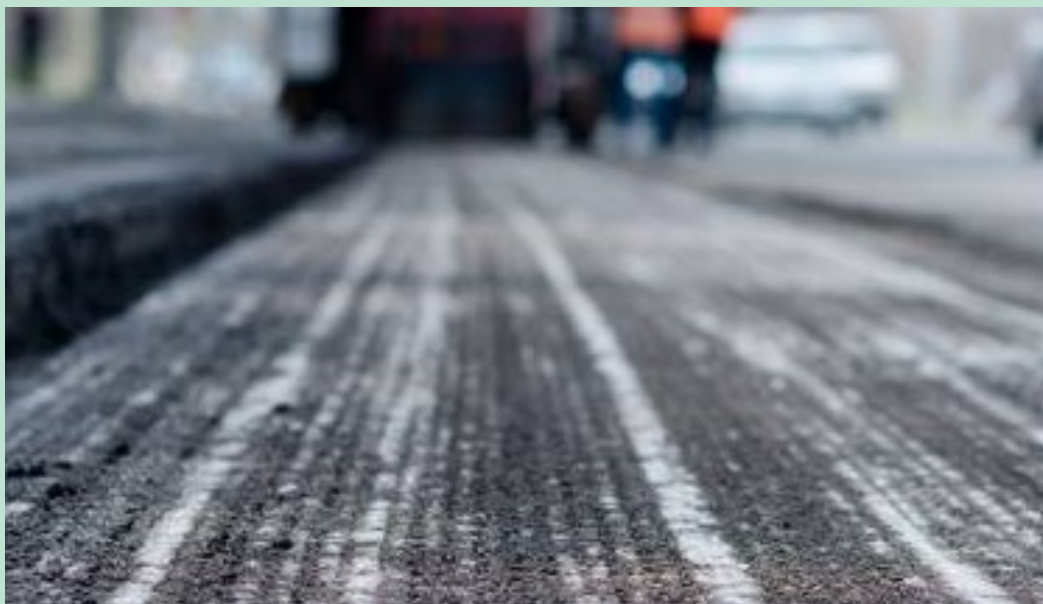
FIGUR 7.4.1. Fræsningens tilrettelægning har indflydelse på det skabte genbrugsmateriales efterfølgende egnethed. Anvendes særlig finfræsning bliver den affræsede overflades "riller" mindre, men der opstår samtidigt forøget nedknusning, så genbrugsegnetheden forringes.
