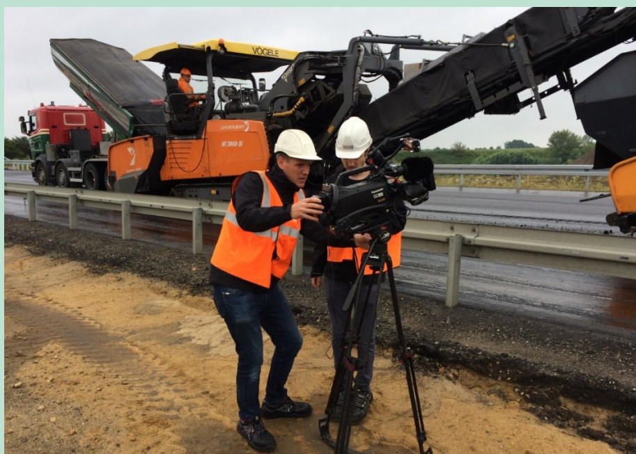
FIGUR 13.1.3. Da det var første gang i Danmarkshistorien, at der blev udlagt et SMA-slidlag med 30 % genbrugsasfalt på en motorvej, var TV2 Midt/Vest's nyhedsreportere naturligvis på pletten for at forevige det bæredygtige initiativ. (Foto: TI).
