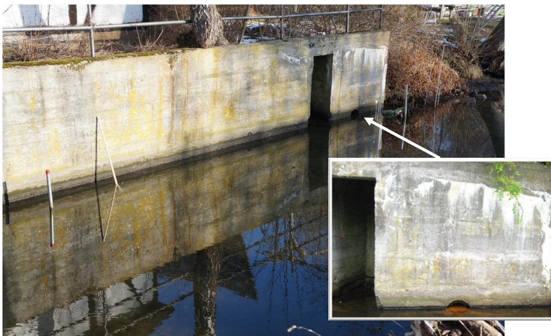
Figur 5.1 Dræn i betonvæk ved Raadvad
