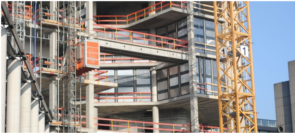
Billede fra byggepladsen ved Panum Institutet i forbindelse med opførelsen af Mærsk Tår-net, hvor modulerne ses i baggrunden.
