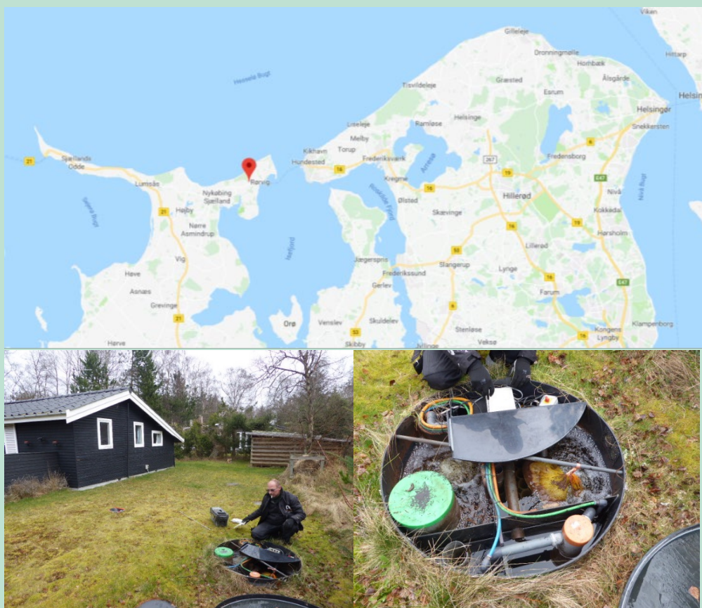
Figur 9-9 BioKube sommerhus renseanlæg nr. 3198 (forsøgsanlæg E, SO anlæg)
