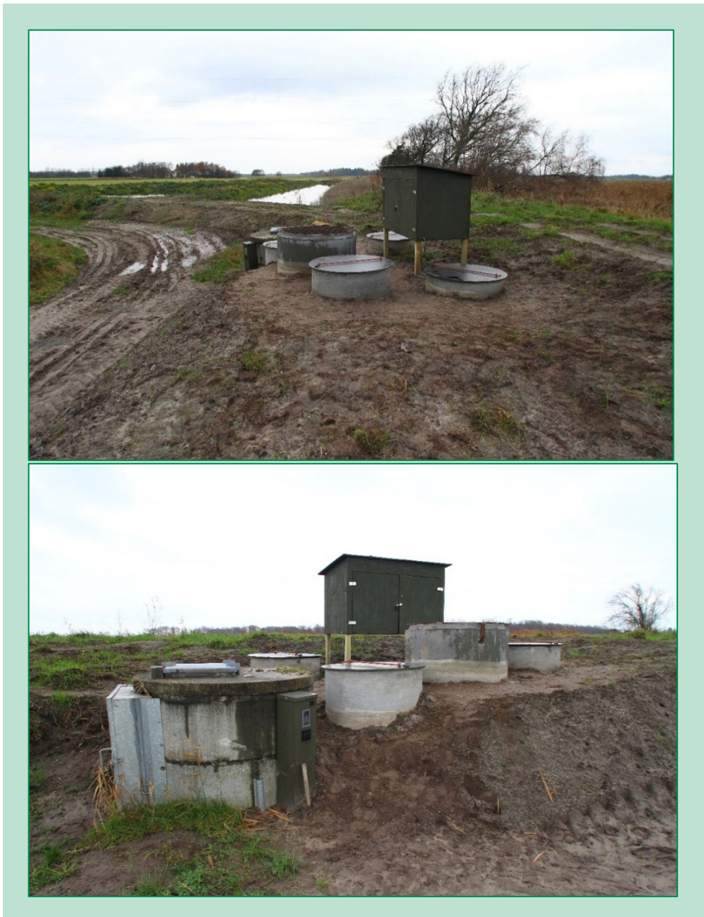
FIGUR 2.4.3. Oversigt over de tekniske installationer med pumpebrønde, fordelerbrønd og målebrønd i området mellem de to minivådområder. Det grønne skur rummer strømforsyning og de ISCO-samlere, der løbende indsamler vandprøver fra den fælles vandforsyning og fra afløbene fra de to minivådområder. Brønden længst til venstre huser den oprindelige pumpe. November 2014.
