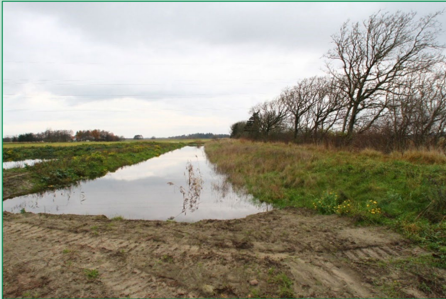
FIGUR 2.2.2. Det store forbassin mellem matriceanlægget og Ryå, set i retning fra syd mod nord kort efter færdigetableringen i 2014.
