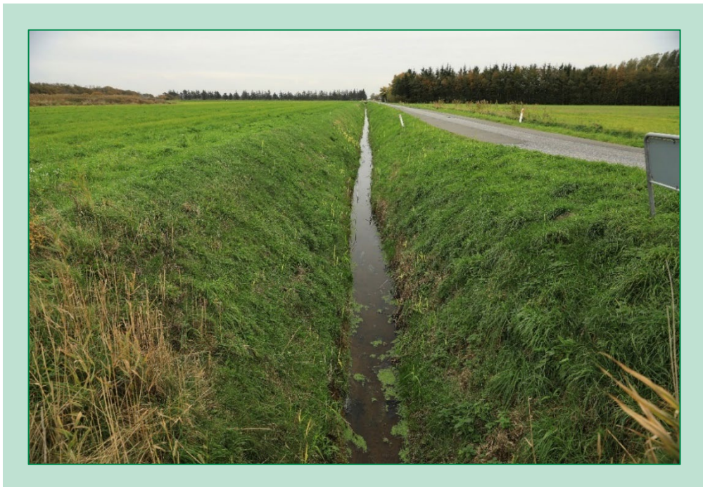
FIGUR 2.1.3. Forbindelsesgrøften langs Slusevej mellem landvindingslagets lille pumpe ved projektområdet og den store pumpe opstrøms Haldager Bro, begge md afløb til Ryå
