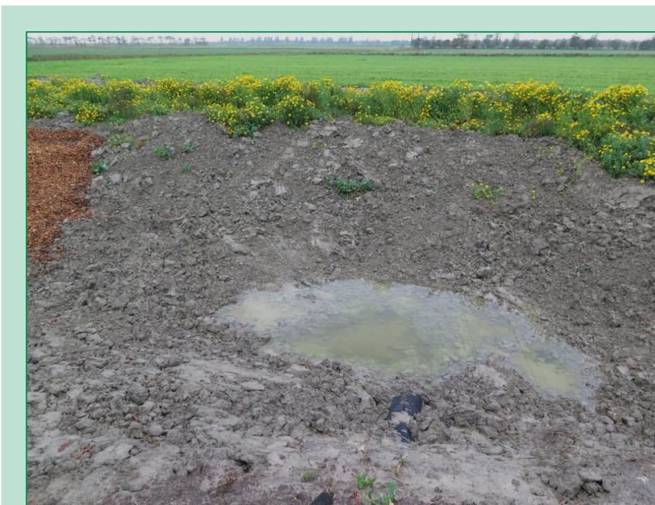
FIGUR 2.2.5. Matriceanlægget er anlagt i/på porøs sandet jord, der via dræn og pumpe er afvandet til mere end 1,5 meters dybde. For at holde vandet i bassinerne var det nødvendigt at fore bassinerne med en lermembran til et stykke op over omgivende terræn.
