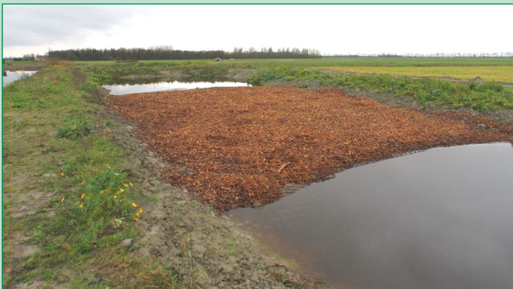
FIGUR 2.2.4. Filtermatricen – bioreaktoren, hvori kvælstoffjernelsen sker ved denitrifikation af drænvandets nitrat - består af grofthakket bøgetræ, øverst set fra syd mod nord, før der blev lukket vand på anlægget, og nederst set fra nord mod syd kort efter at der blev lukket vand på sidst i 2014.
