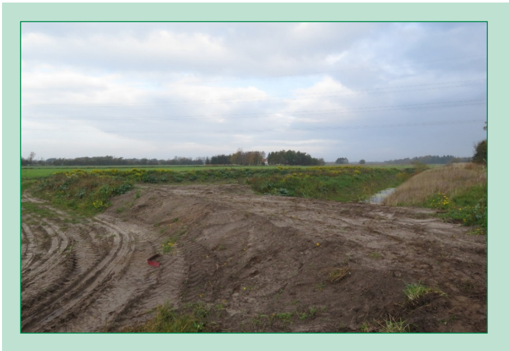
FIGUR 2.2.6. Matriceanlægget er omgivet af ca. 1 meter høje volde for at forhindre udstrømning af vand fra anlægget til de omgivende marker i tilfælde af høje vandstande i anlægget.
