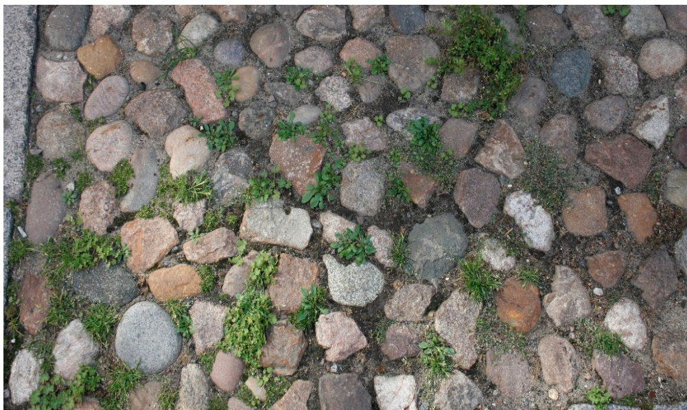
Billede 8. Belægning med store fuger og megen ukrudt (Foto: Anne Mette Dahl Jensen)
