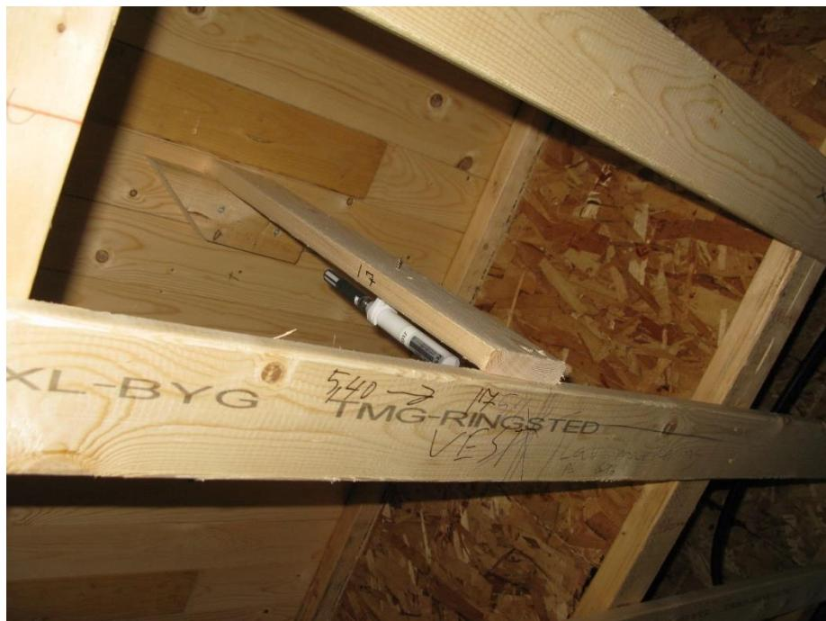
Figur 5. Målepunkt 17 i midten af isoleringen i taget mod vest.
