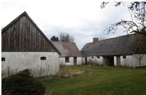
Robstup Vej 15 før nedrivning
