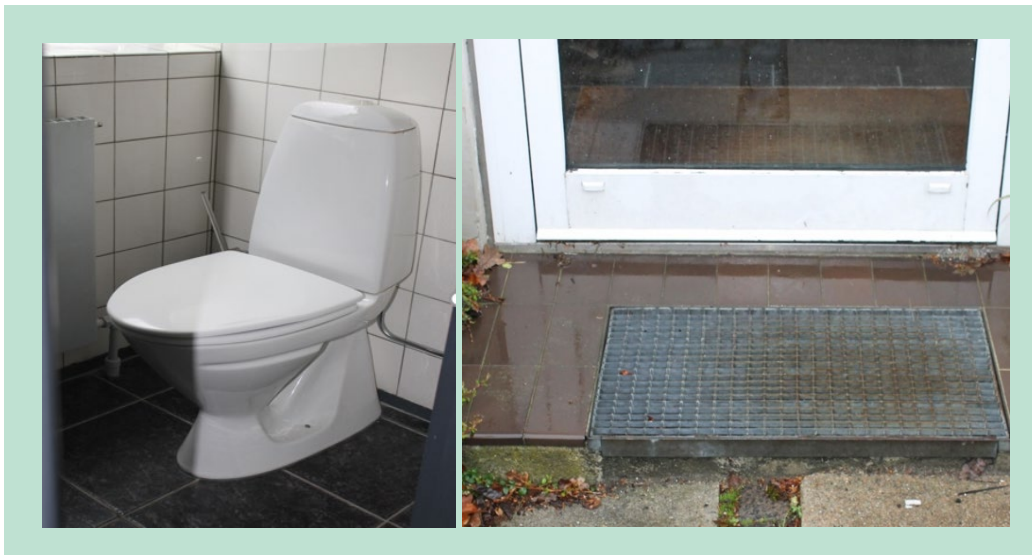
FIGUR 2.4 Eksempler på uglaserede fliser på gulv, glaserede fliser på vægge og glaseret porcelænstoilet (til venstre) samt uglaserede klinker på trappe (til højre). Fotos: Thomas Hougaard.
