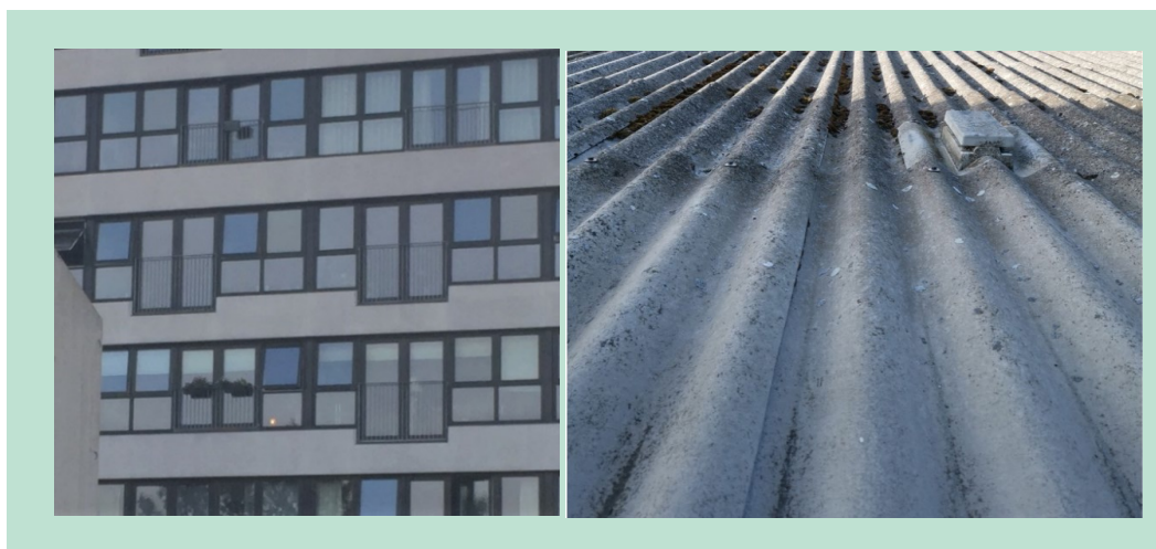
FIGUR 2.2 Til venstre eksempel på facadebeklædningsplader af fibercement (Foto: Thomas Hougaard) og til højre et tag af bølgeeternitplader uden asbest (Foto: Ole Hjelmar).
