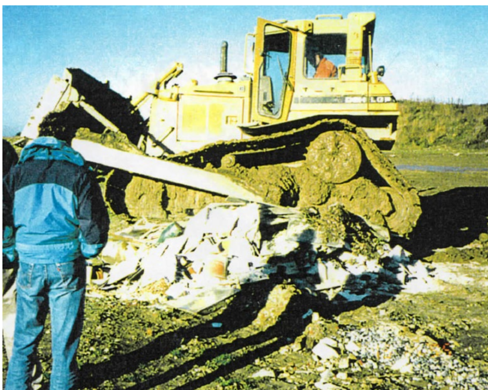
Figur B Grovknusning af læsset af inert affald med dozer.
