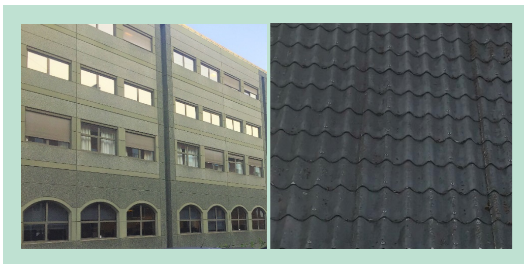
FIGUR 2.1 Til venstre et eksempel på overfladebehandlede betonelementer (Foto: Thomas Hougaard) og til højre sortfarvede eternittagplader (Foto: Ole Hjelmær).
