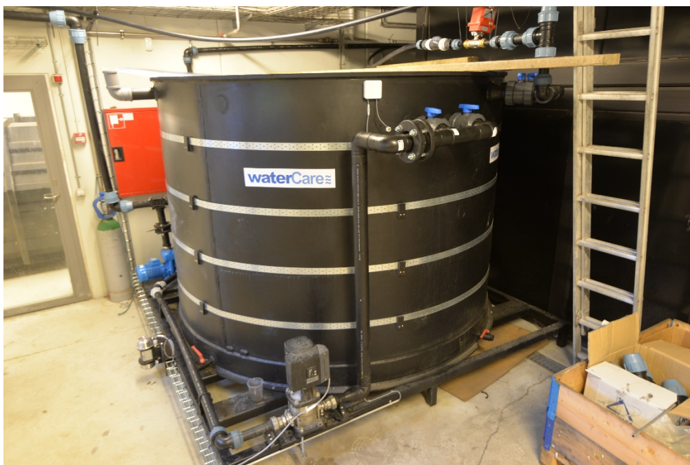
Hver rensetrin fra bundfældningstank over DPF-bokse til sorbenttanke var vigtige for det samlede renseresultat. Foto: Simon Skov
