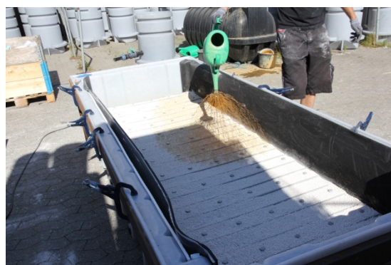
Figur 23: Indlejring af sorbent i stakken af dobbeltporøse lag i hver Watercare-DPF-boks ser ud til at kunne effektiviseres ved brug af en snegl.
