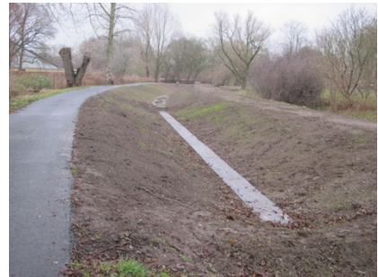
Figur 16: Fotos af DPF-anlæg. Øverst t.v.: Ørestad, set fra indløb mod udløb, før reetablering af terræn, 6-lags version og 18 lags version, hver 2,5 L/s. Øverst t.h.: Allerød, kommercielt anlæg, 18 Watercare-DPF-bokse med spulerør, 20 m forfilter og 40 m hovedfilter, 3 L/s. Nederst t.v.: Mårslet, indbygget i jordvold, 20 m forfilter, 40 m hovedfilter, zig-zag opbygning, 0,5 L/s. Nederst t.h.: Brønshøj, 20 m forfilter i bund af grøft, efterfulgt af 40 m hovedfilter, anes i baggrunden, 0,5 L/s.
