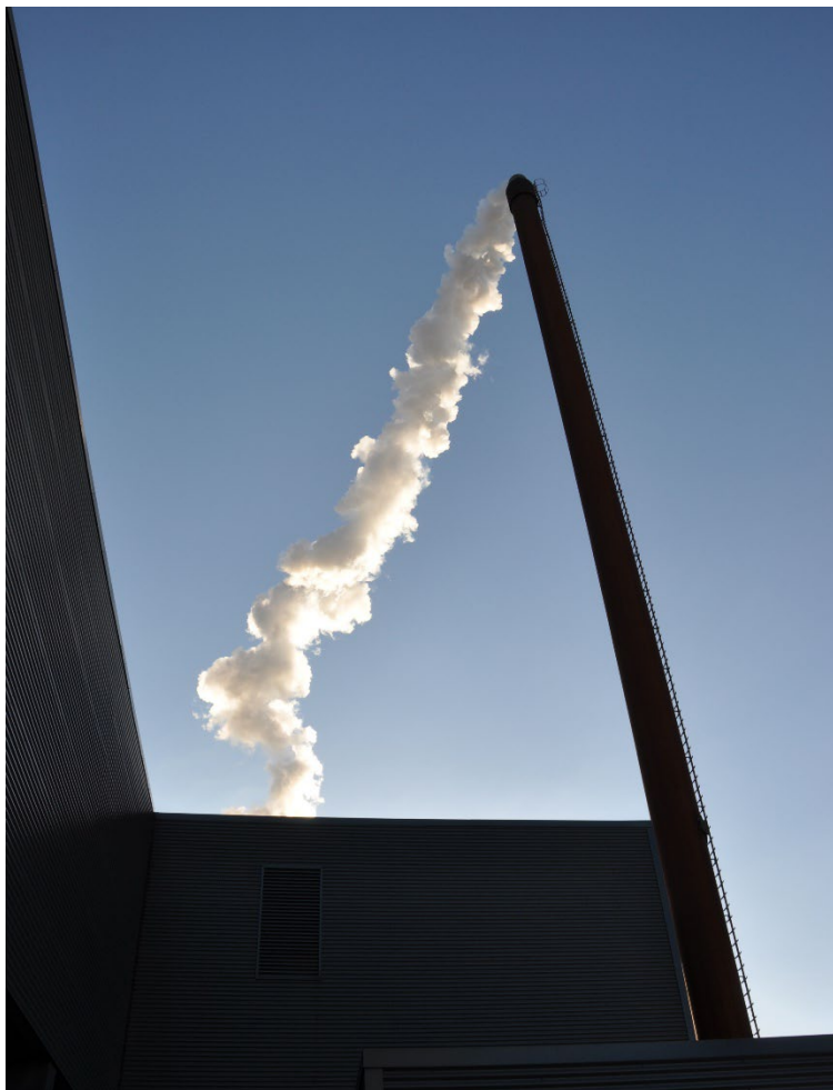
Udover røgen ud af skorstenen udleder flisfyrede varmegærker også kondensatslam, aske og spildevand. Foto: Simon Skov
