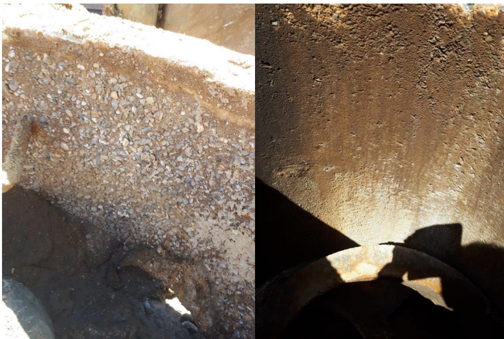
Figur 52. Billeder af gammel brønd på Guldager Stationsvej, cirka 10-15 år gammel ved udskiftning.
