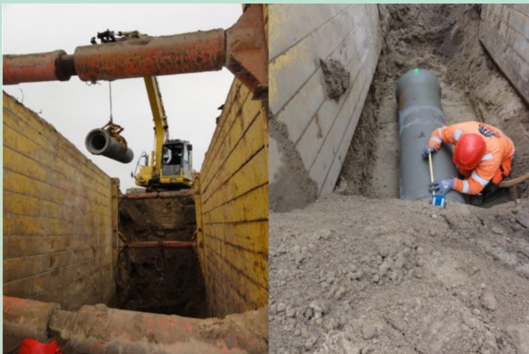
FIGUR 41. Etablering af rørstrækning med kalkrør hos Aalborg Kloak.
