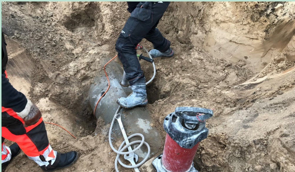
FIGUR 4. Billede af udboring af kerner fra kalkrør etableret i rørprojekt I.
