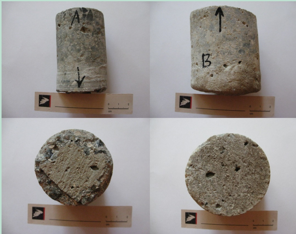
FIGUR 5. Udborede kerner fra kalkrør fra rørprojekt I. Pilen peger mod indersiden af røret. Til venstre: kerne fra toppen, til højre: kerne fra bunden.
