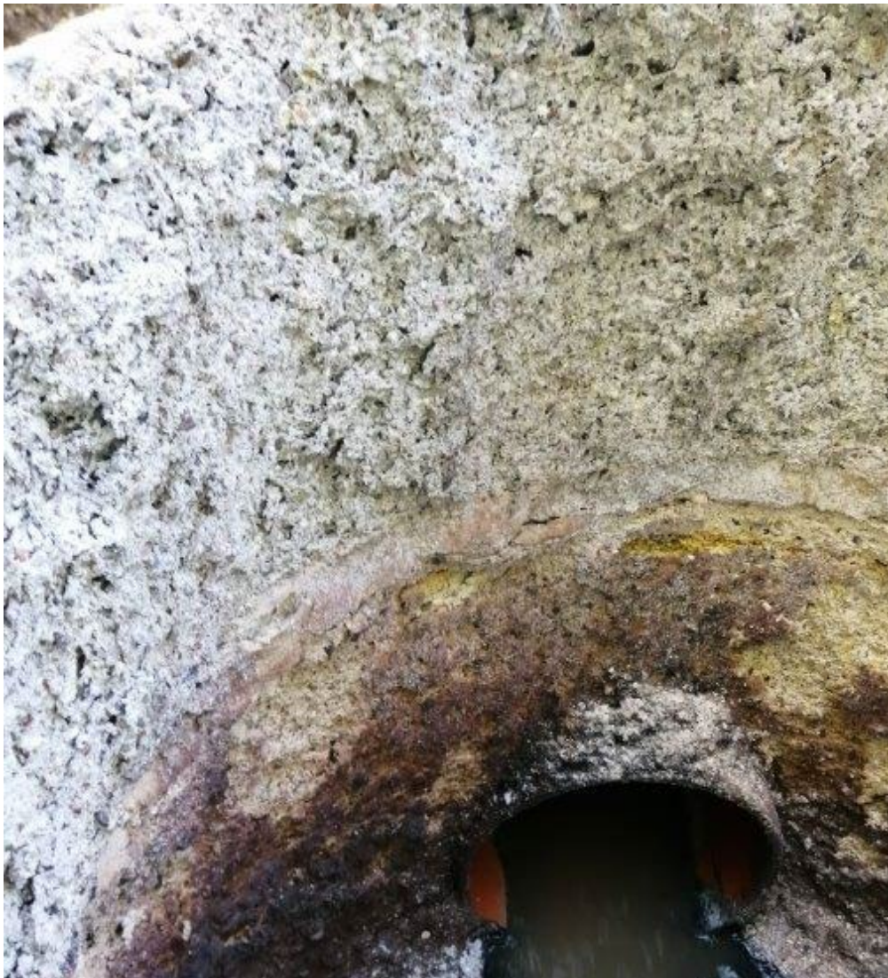
Figur 56. Billeder af gammel brønd på Tjæreborgvej, cirka 15 år gammel ved udskiftning.
