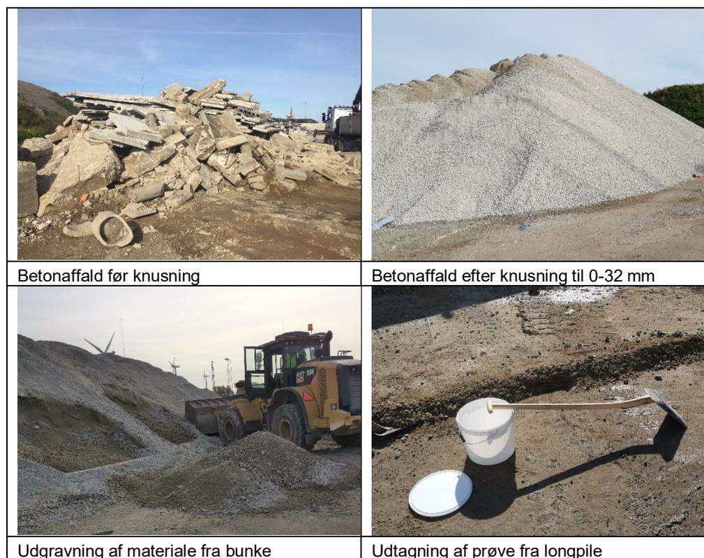
**Figur 2.1** Forskellige trin i processen fra betonbrokker modtaget på behandlingsanlæg til repræsentativ laboratorieprøve til forbehandling.
