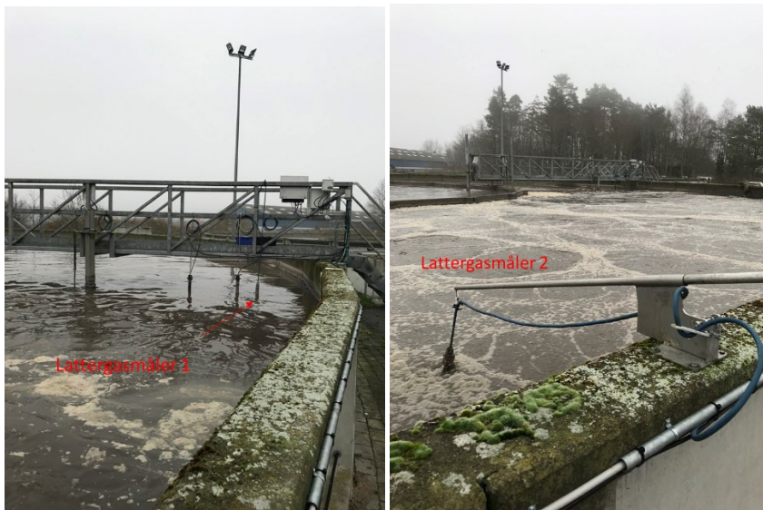
Figur 3: Placering af lattergassensor 1 i den ikke-beluftede-zone og lattergassensor 2 i den beluftede-zone
