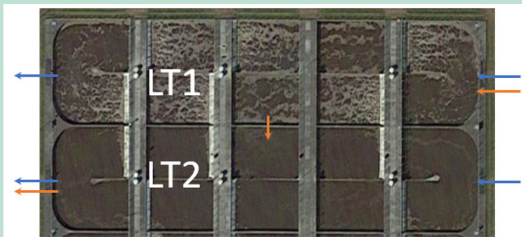
FIGUR 3. De to luftningstanke på Ejby Mølle Renseanlæg. Blå pile indikerer parallel drift og orange pile indikerer seriel drift.
