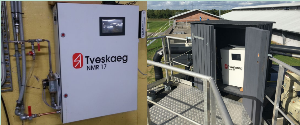
FIGUR 17. Prototype af NMR-måleren på Aalborg RA vest (tv) og Grindsted RA (th)
