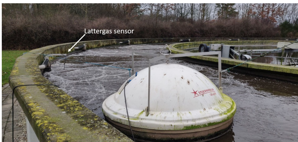
Figur 1: Hyllingeriis renseanlæg set fra oven, med lattergassensor anvist (Rød)
