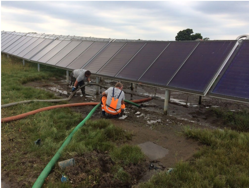
FIGUR 14. Opsamling af spildt solvarmevæske efter brud på rørføring og stophane på anlæg ved Silkeborg.
