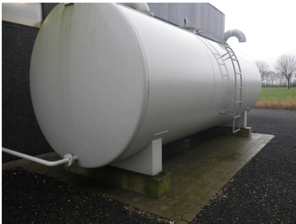
FIGUR 6. Opsamlingstank på solvarmeanlæg i Hedensted. Tanken har en kapacitet på 25.000 liter og skal kunne opsamle solvarmevæske fra anlæggets ca. 11.000 m 2 solfangere. Anlægget indeholder i alt ca. 28.000 liter solvarmevæske, men der er skønsmæssigt kun 2/3 af væsken der kan blæses af ved kogning.
