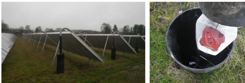
FIGUR 4. Rækker med solfingere (til venstre). Samling/omløber ovenfor nedgravede præisolerede stålør (til højre).
