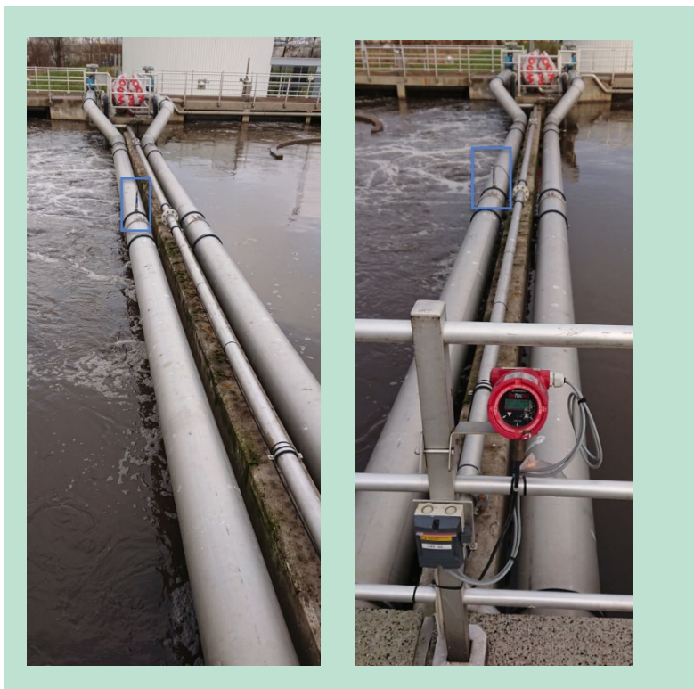
FIGUR 7. TV: Placering af luftflowmåler, markeret med blå, til PT1 med overholdt respektafstande. TH: Placering af luftflowmåler, markeret med blå, til PT3 med overholdte respektafstande. Der ses ligeledes et rødt display til manuel aflæsning af flow.
