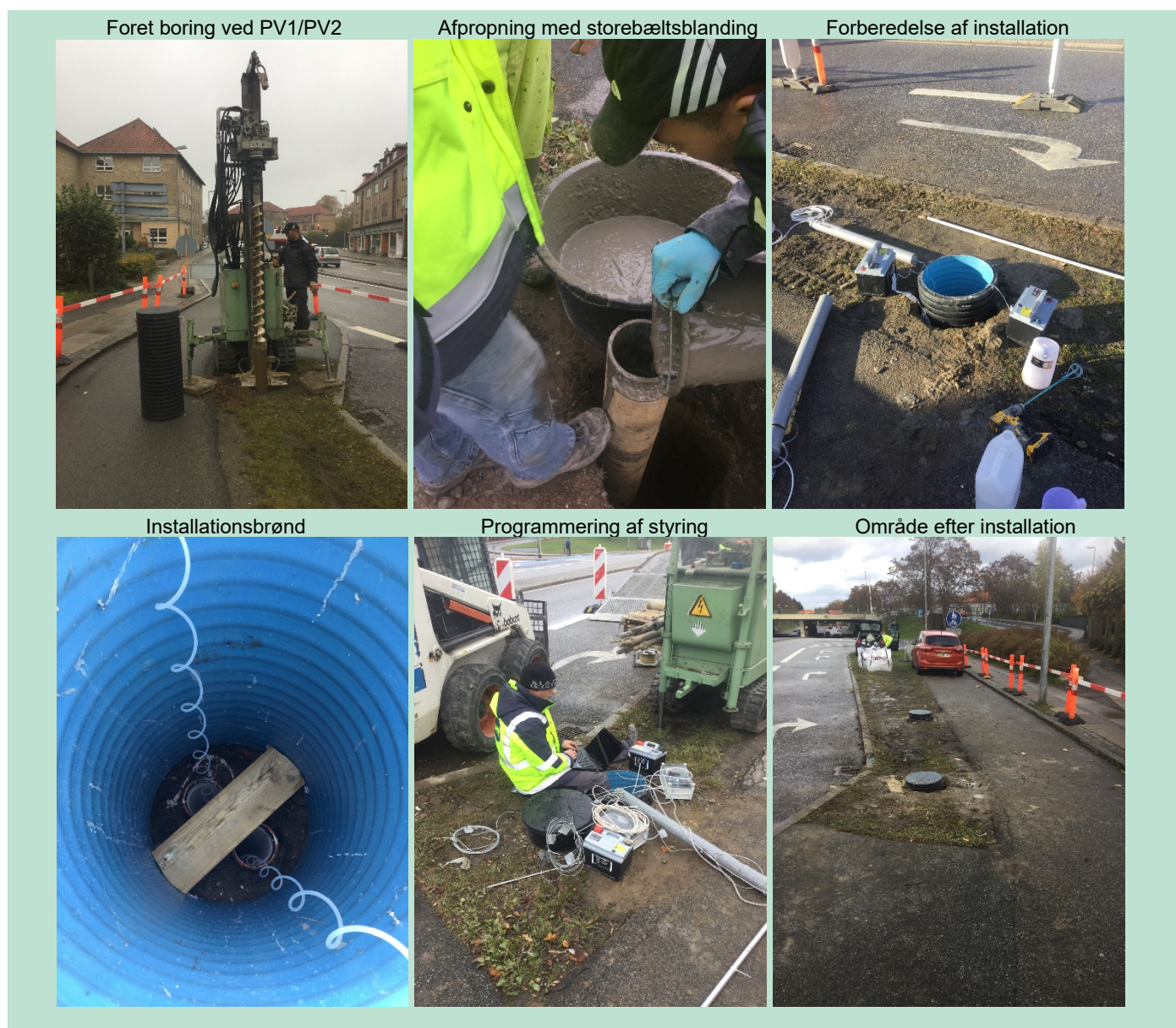
FIGUR 8.4. Fotos fra installation af sugeceller.
