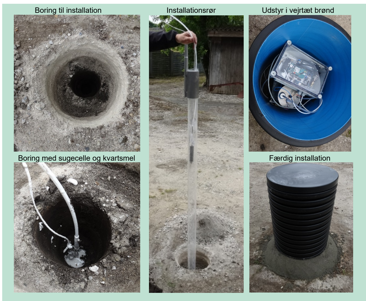
FIGUR 3.4. Fotos fra terrænnær installation af porevandsprøvetager.
