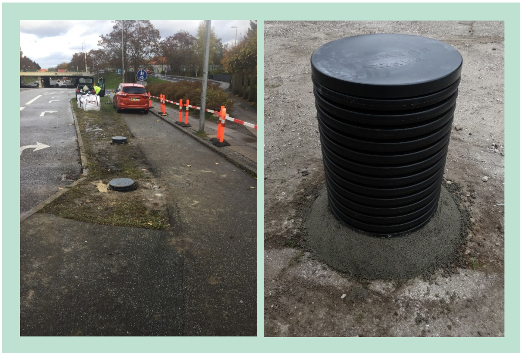
FIGUR 5.2. Nedgravede installationsbrønde (til venstre) samt brønd over terræn (til højre).
