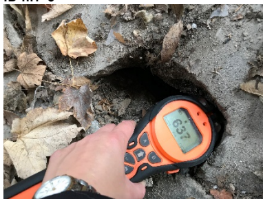
PID måling ved dæksel
