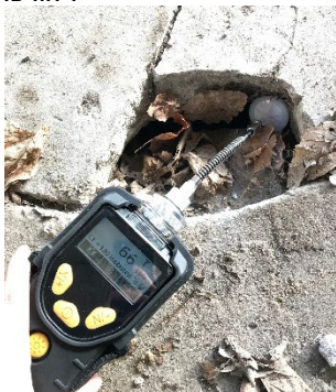
Måling under brønddæksel
