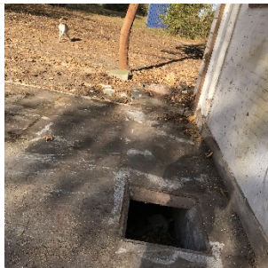
Kanel i fundament til ventilation
