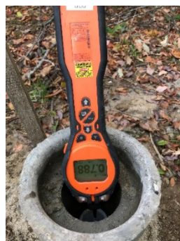
Måling i boring (B1) NB: måling i ppm
