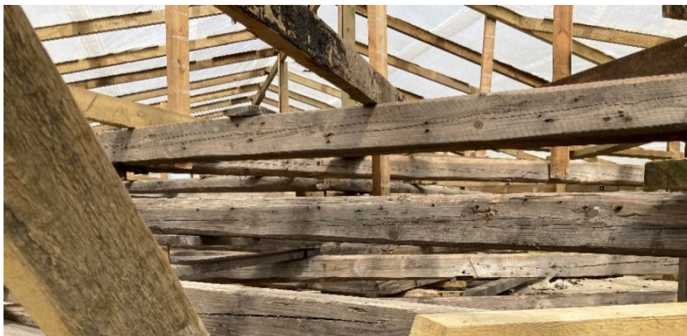
Tagspær opmagasineret under presenning på byggepladsen
