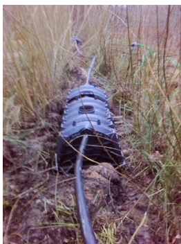
Tomt rum med overdækning af regnvandstunnel. Foto: Peder S. Gregersen
