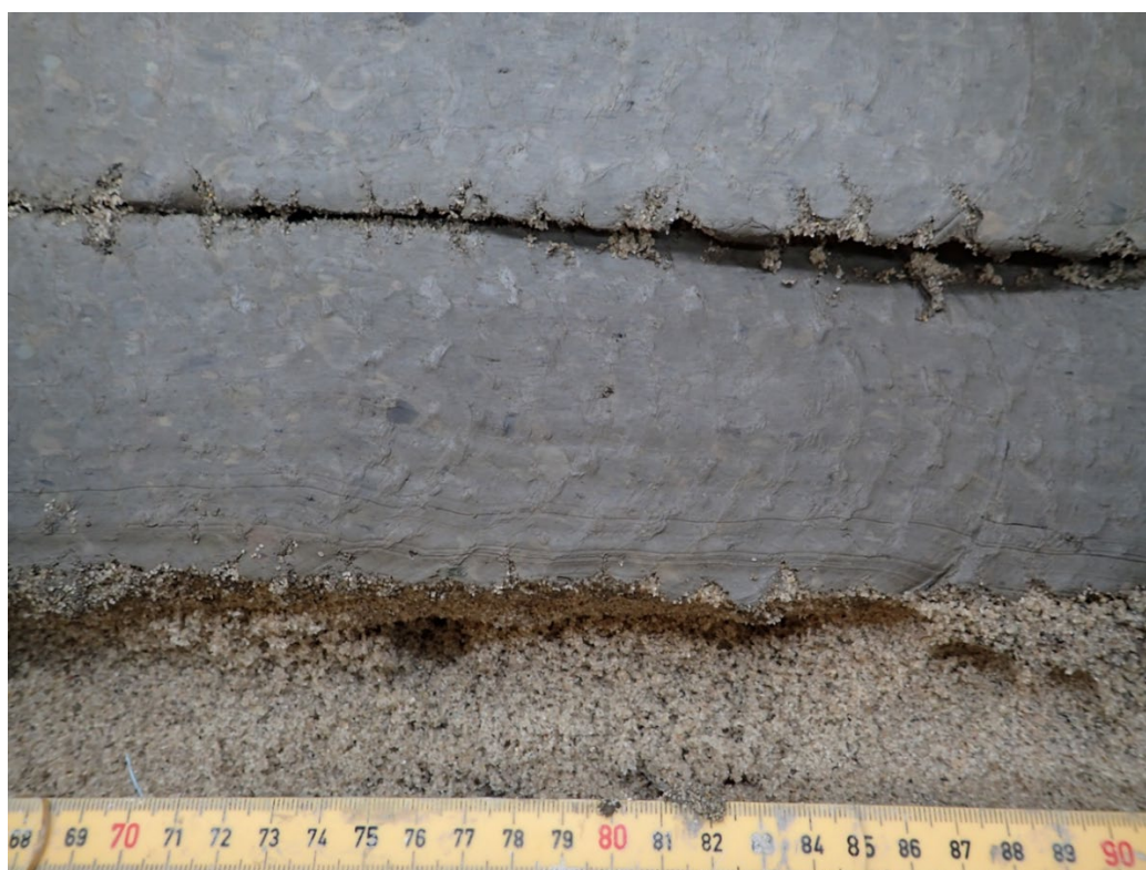
Fig. 1.4.11 Rør 3 Ingen regn. Dantoplug Super. Nærbillede af homogen pelletsforsegling i umættet sand
