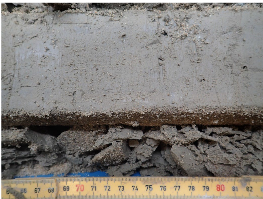
Fig. 1.4.14 Rør 8 med grout (80/20 bentonit/cement). Har opnået en fasthed som kan sammenlignes med en forsegling af Dantoplug Super
