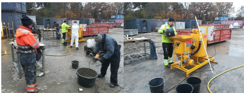
Fig 2.1.2 Projektgruppen i aktion med blanding af grout
