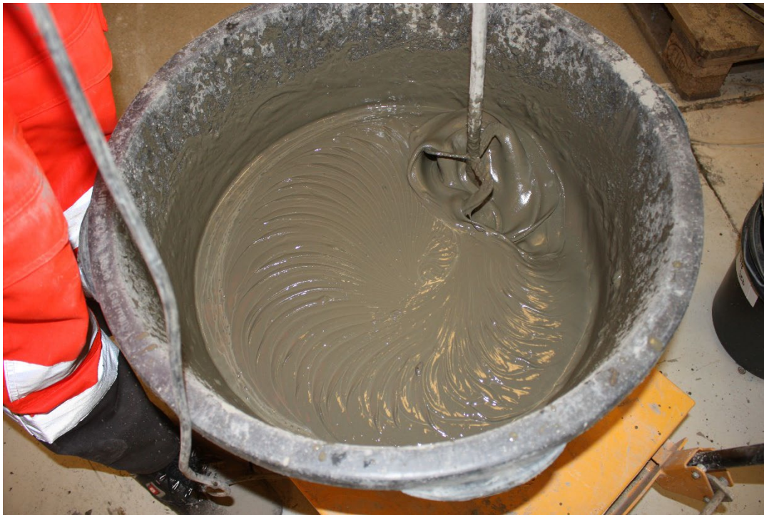
Fig. 2.3.2 Blanding af grout
